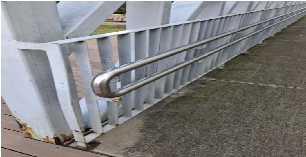
Fotografía 2 Estado actual de la baranda (fuente propia)
