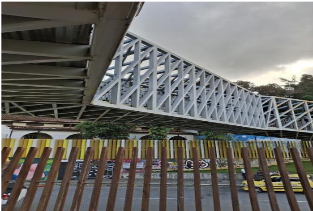
Fotografía 6 línea geométrica del puente al atravesar la vía sobre el intercambiador.
