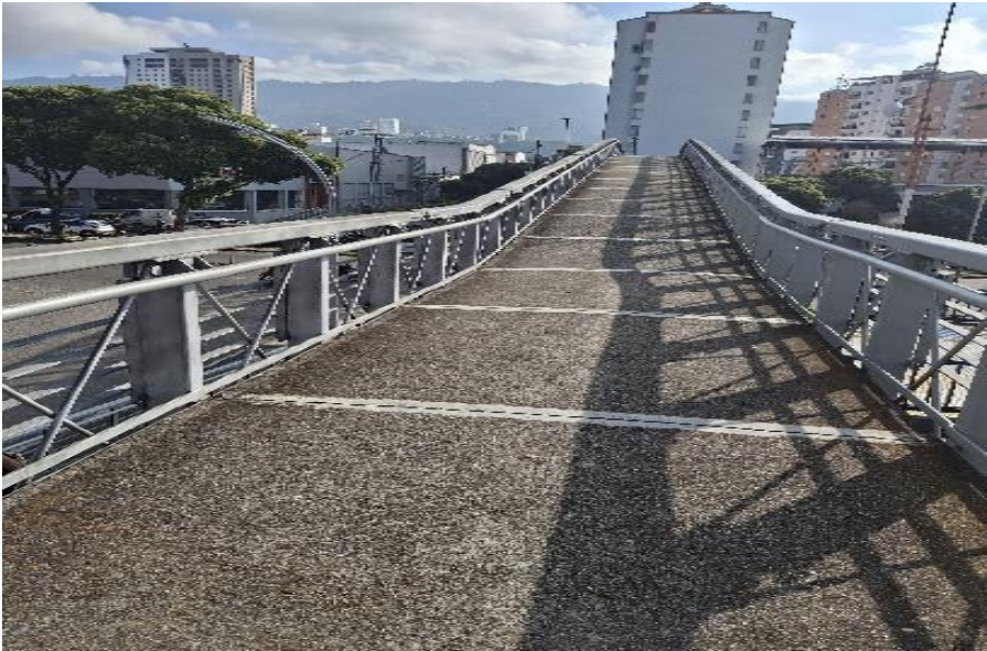
Fotografía 3 Evidencia estado actual de la losa principal en concreto ( fuente propia)
