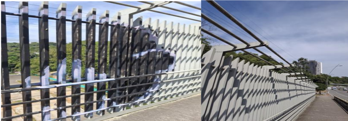
Fotografía 2 y 3 Estado actual del sistema de cerramiento del puente
