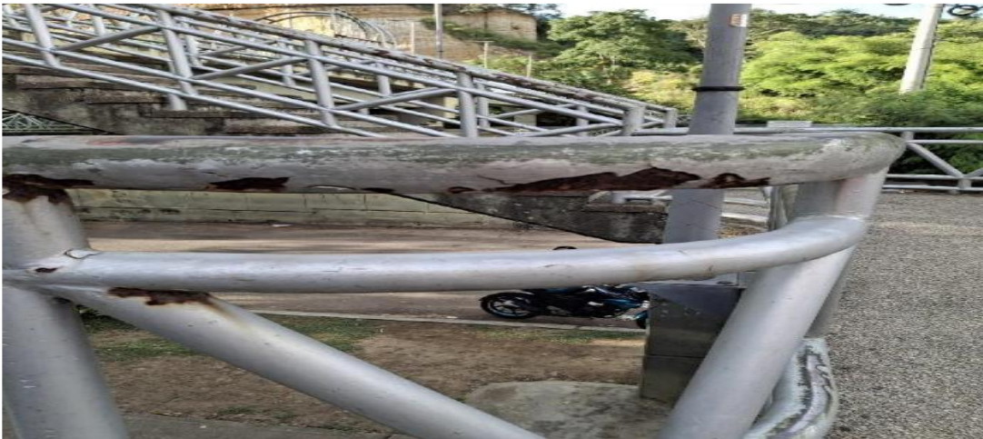
Fotografía 2 Estado actual del sistema de barandas
