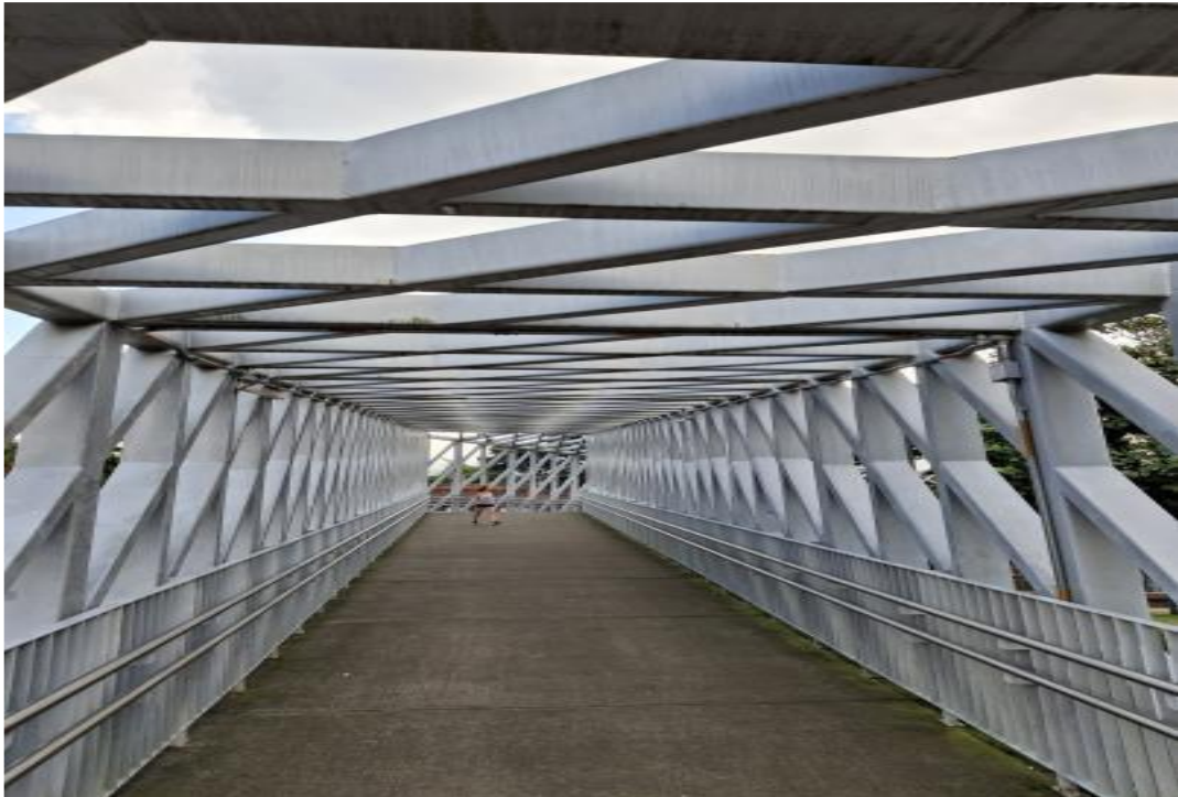
Fotografía 1 Estado actual del interior del puente conformados por sistema de cerchas metálicas que conforman el cajón (fuente propia)
