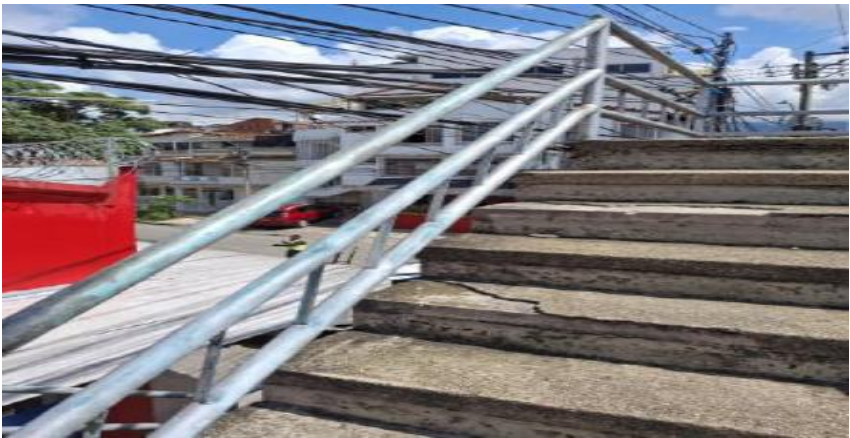
Fotografía 6 evidencia estado del sistema de acceso desde el costado norte a través de escaleras (fuente propia)
