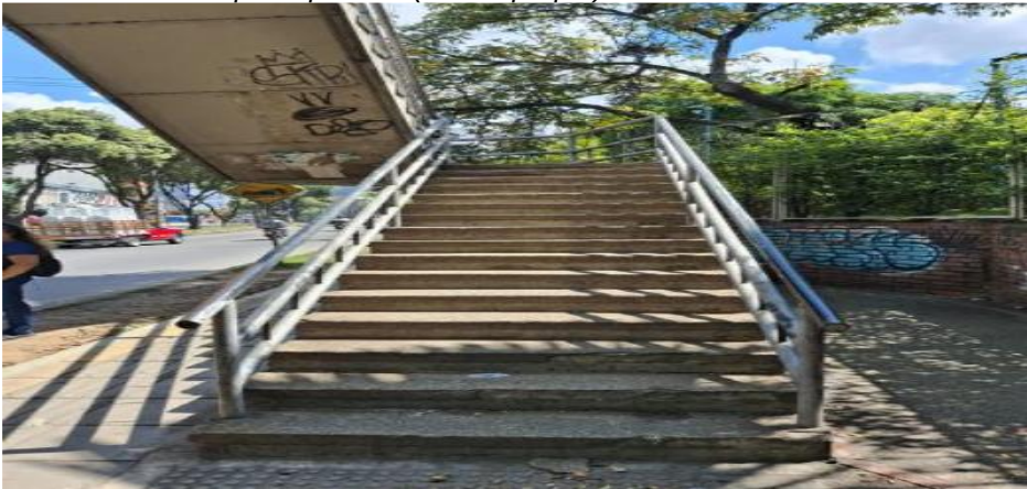
Fotografía 3. Sistema de acceso al puente a través de escaleras desde el costado sur en 2 tramos con descanso ( fuente propia)
