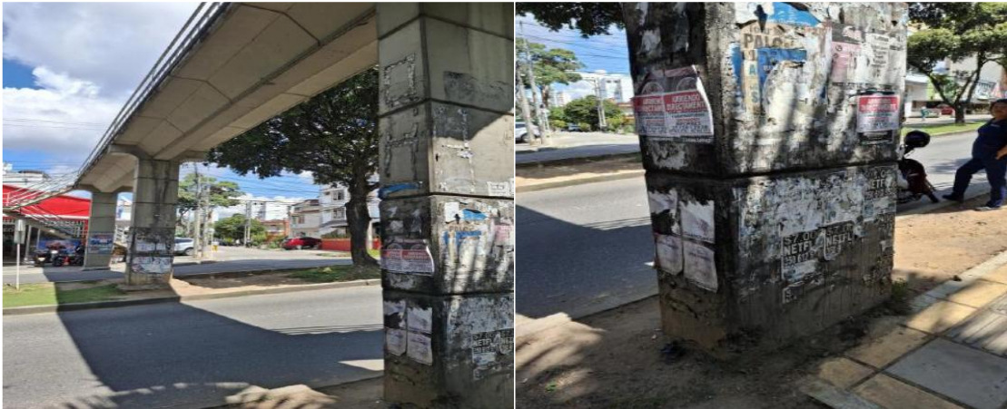
Fotografía 1 y 2 Aspecto general del puente en concreto reforzado soportado por 3 pilares. (fuente propia)
