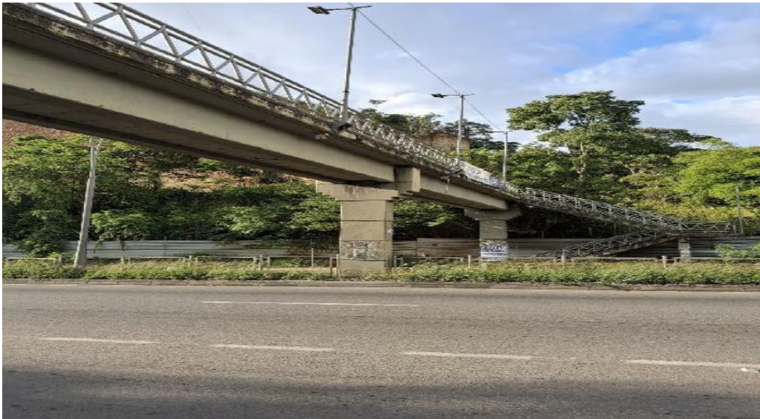
Fotografía 3 Aspecto general del puente representado por pilares en concreto reforzado con soporte para sostenimiento de vigas que conforman el área de transito del usuario y protegido a través de barandas metálicas (fuente propia).
