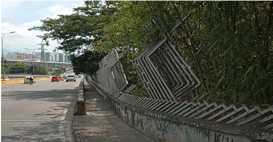
Fotografía 1 Estado actual de la estructura de barandas y tubería (fuente propia)
