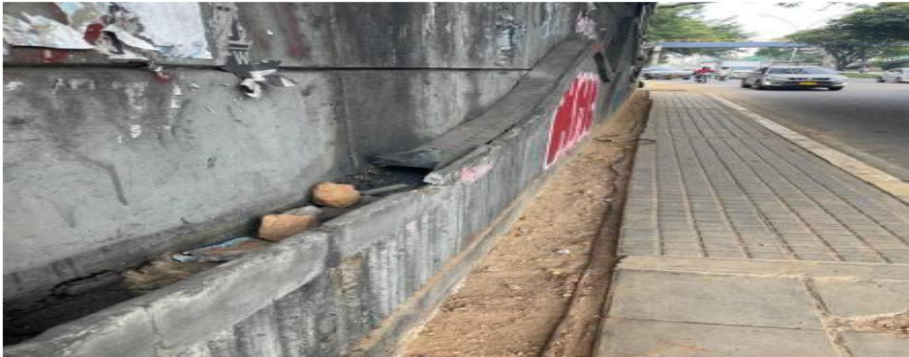
Fotografía 1 Estado actual de los muros del puente. (fuente propia)
