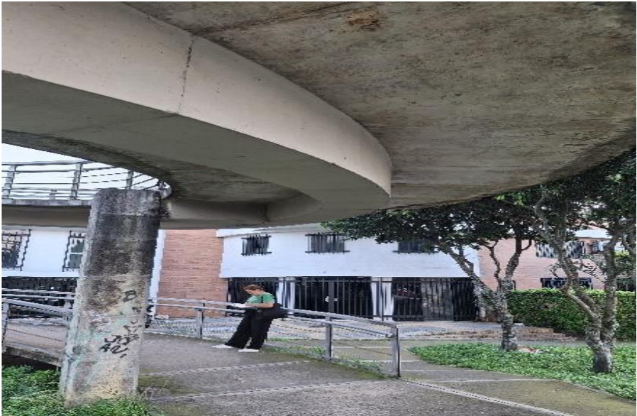
Fotografía 4 Estado actual del costado oriental en rampa tipo espiral soportado en viga principal tipo avión ( fuente propia)
