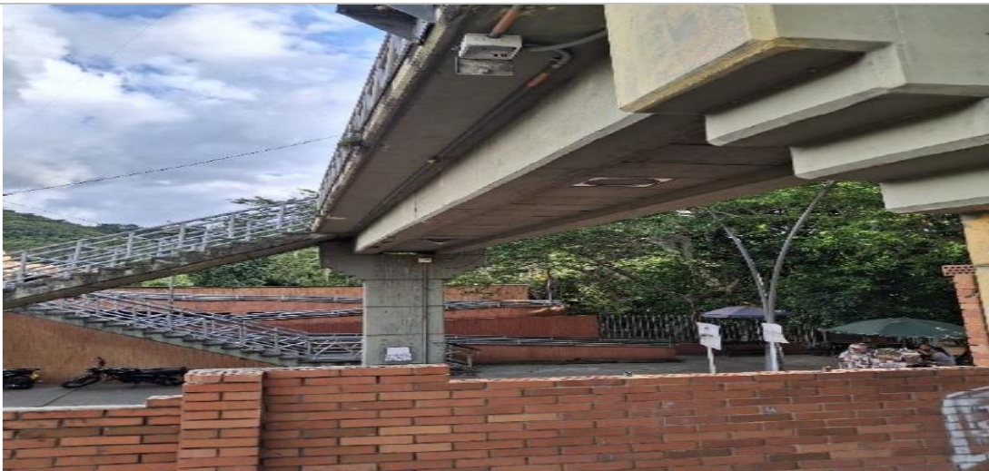
Fotografía 1 Aspecto general del puente en concreto reforzado soportado por pilares (fuente propia)
