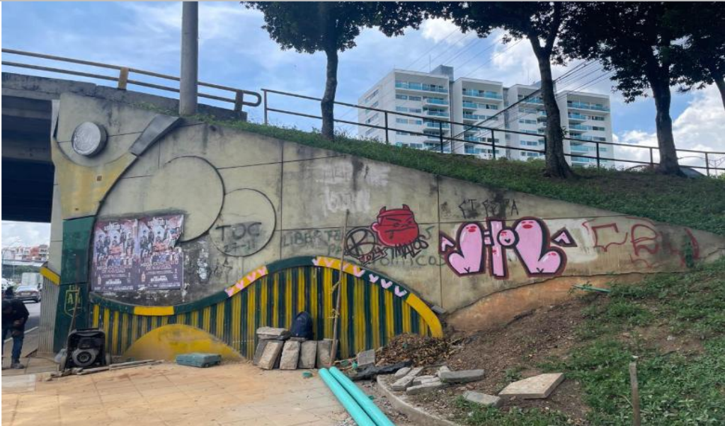
Fotografía 6 Estado actual de los muros en concreto. (fuente propia)
