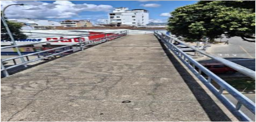
Fotografía 5 Estado actual del puente en estado normal y protección del usuario a través de barandas metálicas.(fuente propia)
