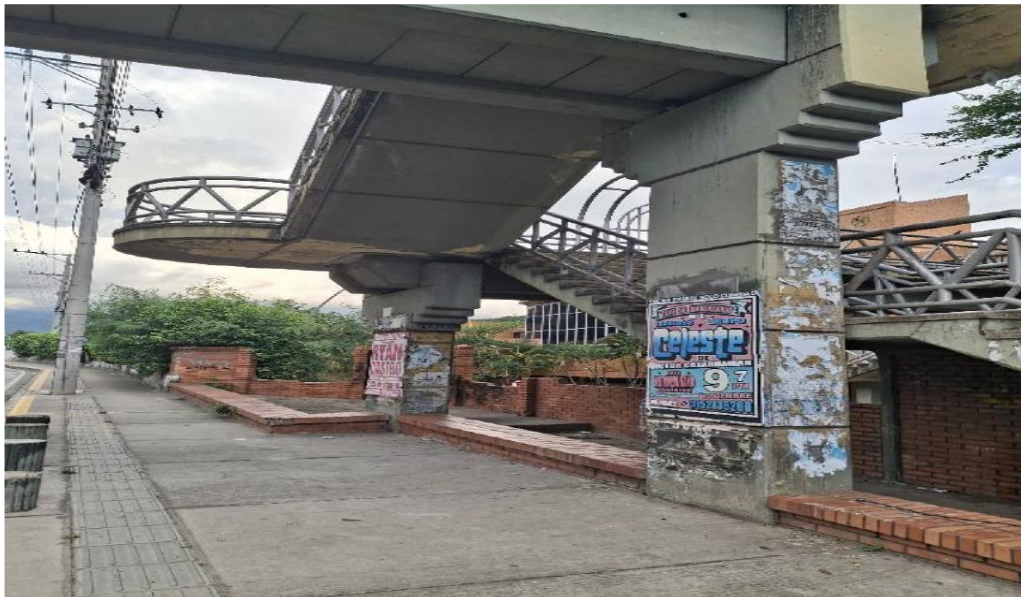
Fotografía 5 Estado actual del sistema de acceso desde el costado sur a través de escaleras. (fuente propia)
