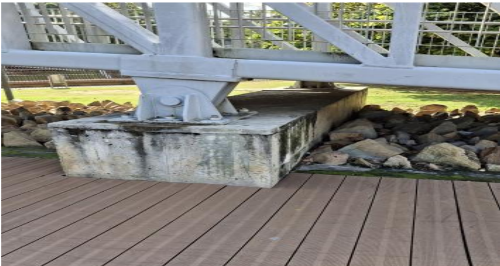
Fotografía 4 Estado actual del soporte del puente (fuente propia)
