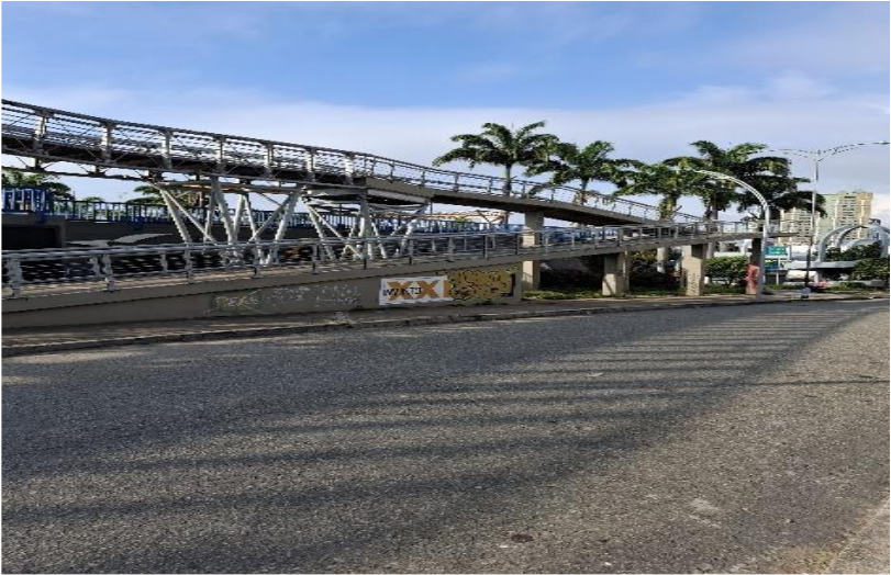
Fotografía 1 sistema de acceso del costado occidental en rampas sobre estructura de concreto que soporta placa fundida en metaldeck que igualmente esta soportada por pilares (fuente propia).
