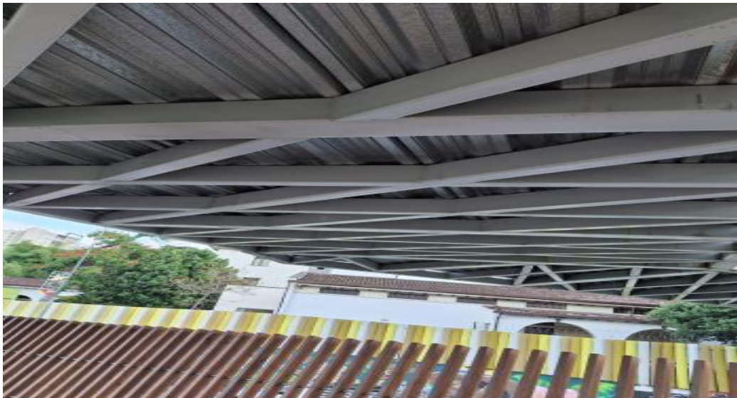
Fotografía 3 estado actual de la parte inferior del puente donde se aprecia la losa de concreto para transito (fuente propia)
