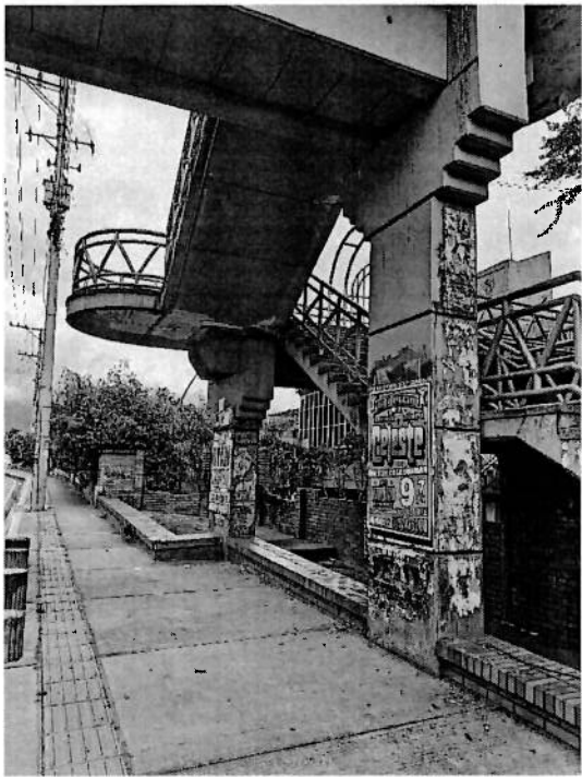
Sistema de acceso desde el costado sur a través de escaleras
