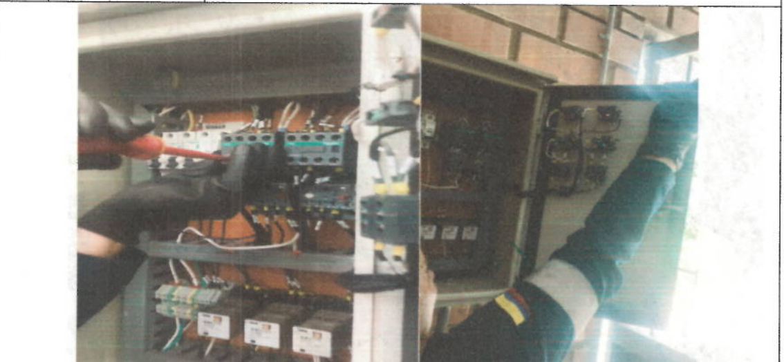
12. 04 febrero 2026 a 12 marzo 2026 Revisión y mantenimiento a cabezotes del compresor – Compresor y cabezotes 1 y 2
