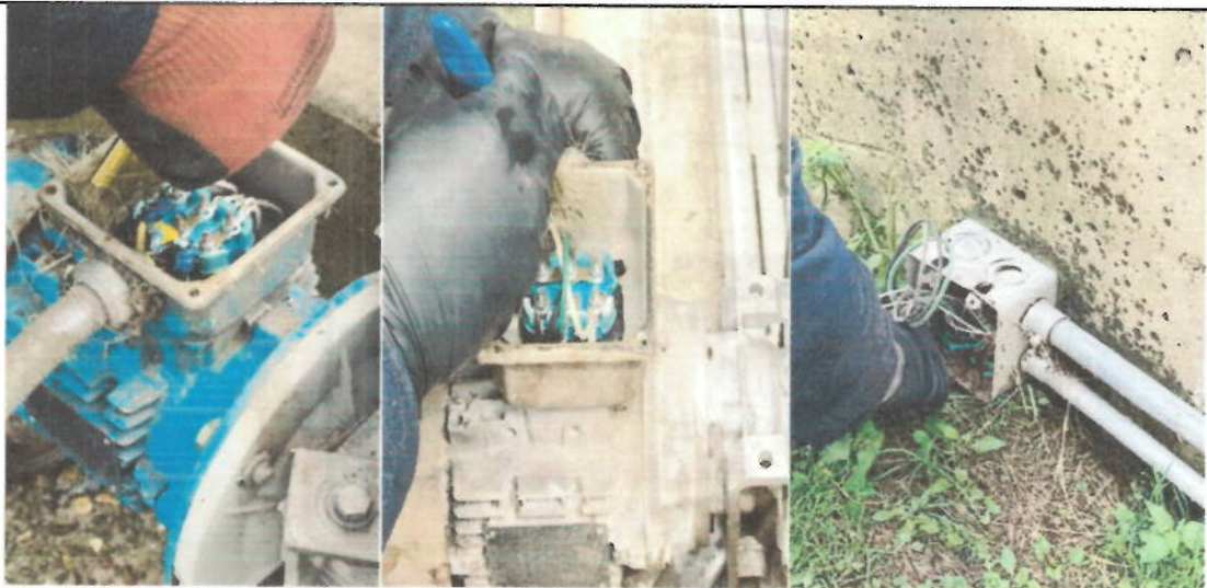
4. 04 febrero 2026 a 12 marzo 2026 Mantenimiento a tablero eléctrico – Tamiz rotativo
