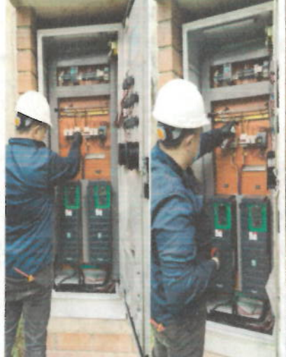
6. 04 febrero 2026 a 12 marzo 2026 Mantenimiento a tablero eléctrico – Sistema de distribución filtro percolador
