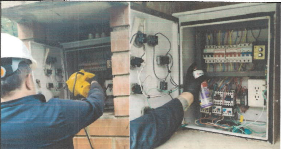
5. 04 febrero 2026 a 12 marzo 2026 Mantenimiento a tablero eléctrico – Bomba sumergible 1 y 2 de tanque homogenizador
