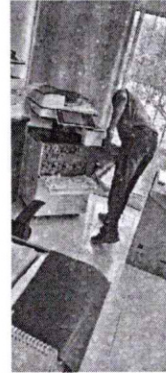
EVIDENCIA 2 Revisión del equipo durante la ejecución del mantenimiento.
