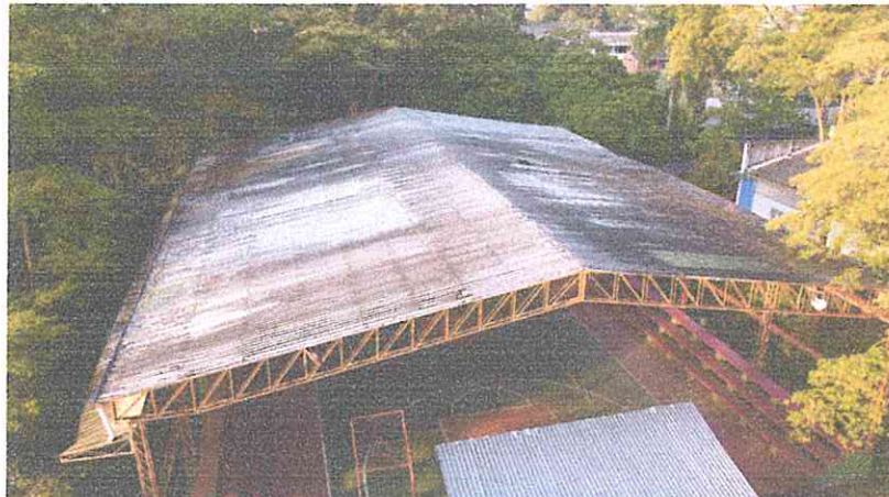
Imágenes fotográficas propias Visita Instituto Técnico Industrial, recorrido junto al Supervisor del Contrato donde se socializó el alcance y estado de las actividades en sitio
