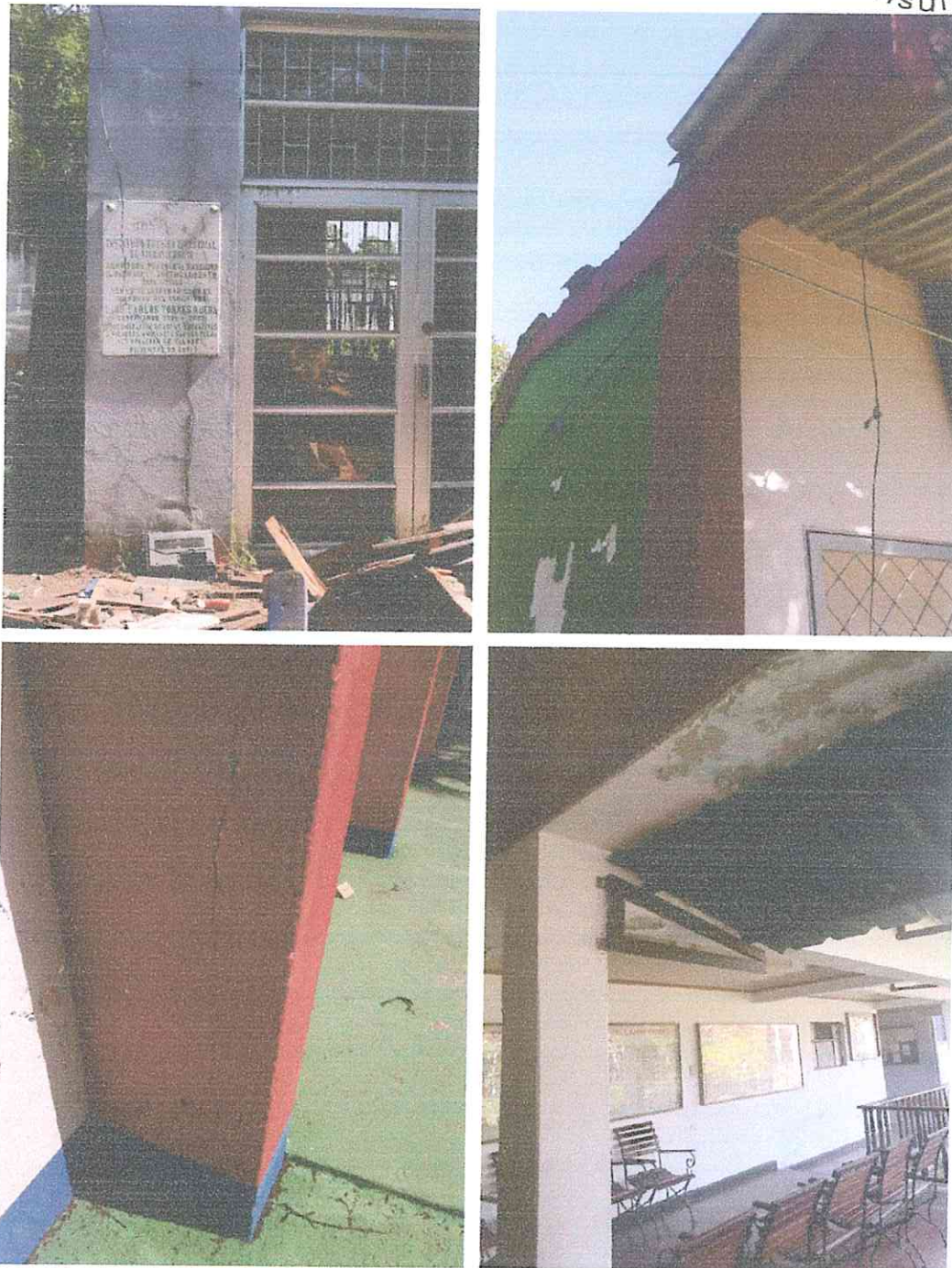
Imágenes fotográficas propias Visita Instituto Técnico Industrial, recorrido junto al Supervisor del Contrato donde se socializó el alcance y estado de las actividades en sitio
