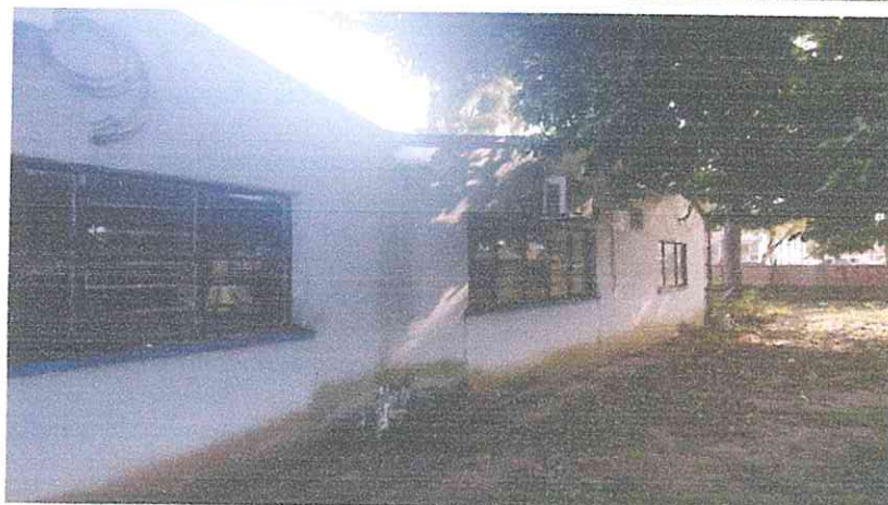
Imágenes fotográficas propias Visita Instituto Técnico Industrial, recorrido junto al Supervisor del Contrato donde se socializó el alcance y estado de las actividades en sitio
