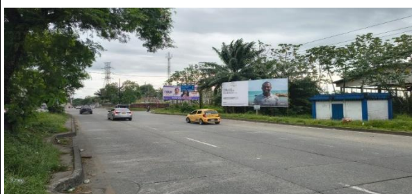
Registro Fotográfico 5. Instalación de valla Fuente: Consorcio Interdragado BV
