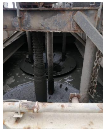
Monitoreo de material en tolva 7 junio- 2026
