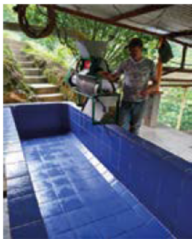
Tanque tina de concreto con esquinas internas en ángulo de 90° que propician la acumulación de microorganismos no deseables.
