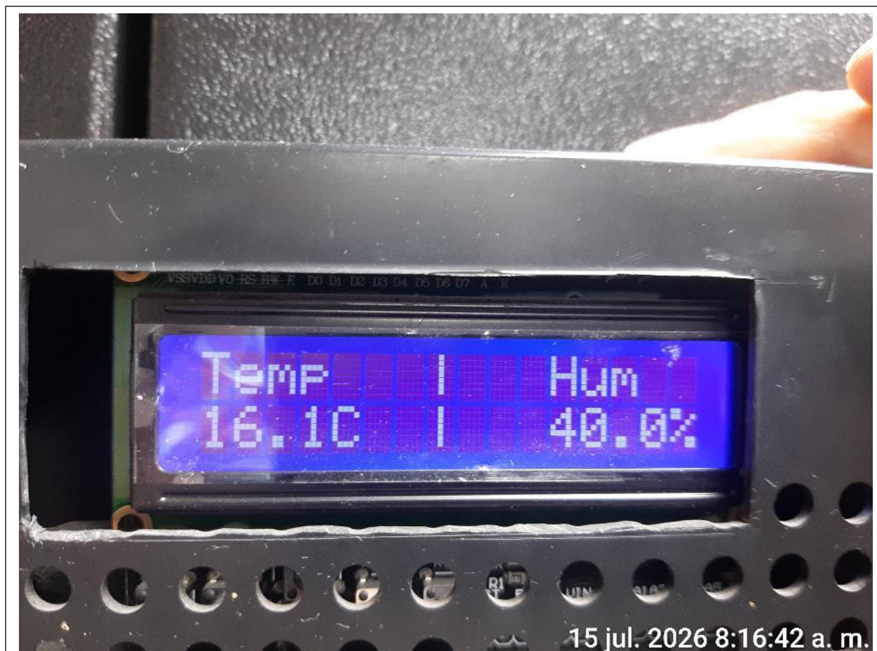
Foto 12. Detalle de lectura de humedad relativa de 40% y temperatura de 16.1°C para soporte medio óptico durante la visita del 15 de julio de 2026, la cual está de conformidad con lo estipulado en el numeral 4.2. del Anexo del contrato.
