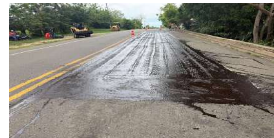
Sellado de fisuras - El viajano -San Marcos
