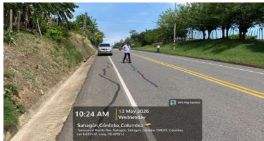
Visita de inspección - El viajano -San Marcos
