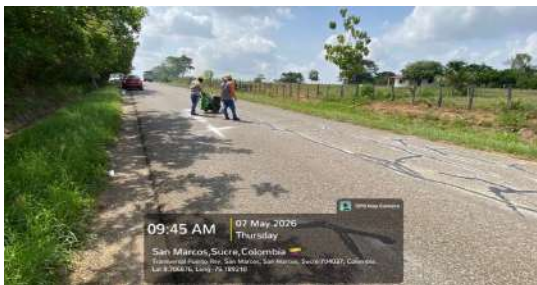
Sellado de fisuras - El viajano -San Marcos
