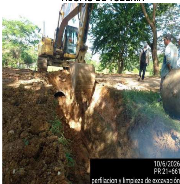
PR21+660 9 JUN 2026 EXCAVACION DE LA ALCANTRILLA
