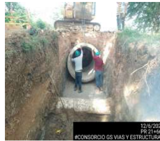
Instalación de tubería en el PR21+660 Tramo Loric- Chinú
