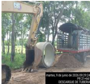
Descargue de tubería - Loric-Chinú
