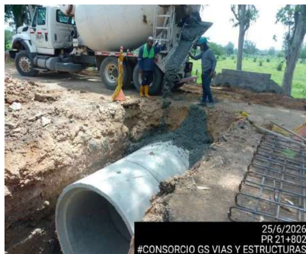
PR21+802 25 JUN 2026 COCRETRO PARA ATRAQUE DE TUBERIA
