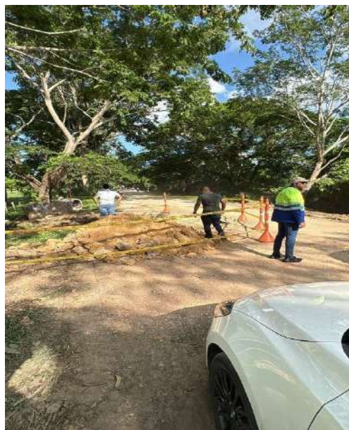
11 DE JUNIO 2026 VISITA DE AQUALIA PARA EL RETIRO DE TUBERIA EN EL TRAMO DE OBRA
