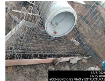
Figuración de acero para cabezal en el PR22+040 Tramo Loric- Chinú
