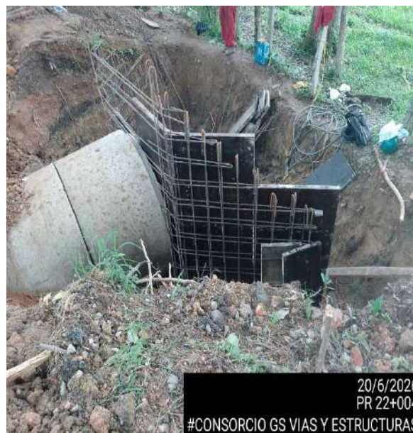
PR22+040 20 JUN 2026 INTALACION DE ACERO Y FORMALETA PARA CABAEZAL
