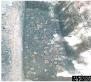
Concreto ciclopeo en alcantarilla PR21+660 Tramo
