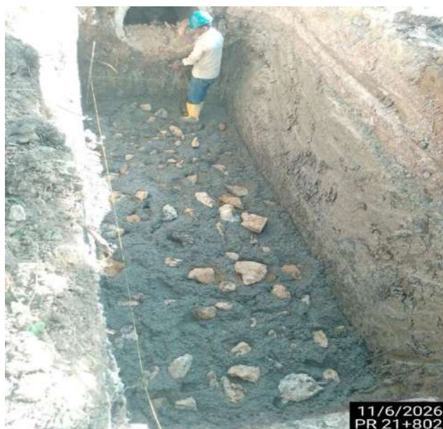
PR21+802 11 DE JUNIO 2026 CONCRETO CICLOPEO
