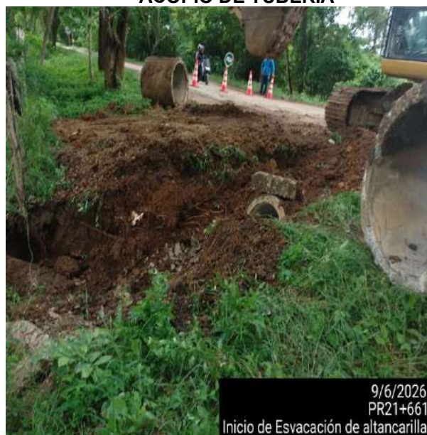
PR21+660 9 JUN 2026 EXCAVACION DE LA ALCANTRILLA
