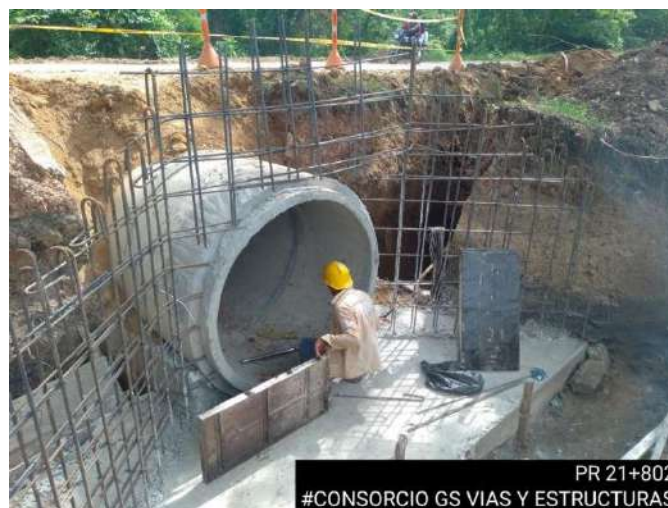
PR 21+802 29 DE JUN 2026 INSTALACION DE ACERO
