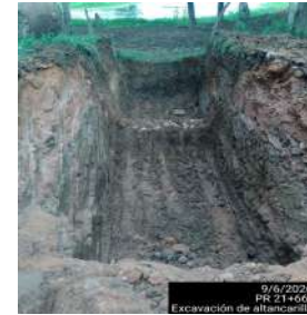
Excavación alcantarilla PR21+660
