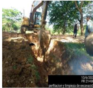
Excavación alcantarilla PR21+660
