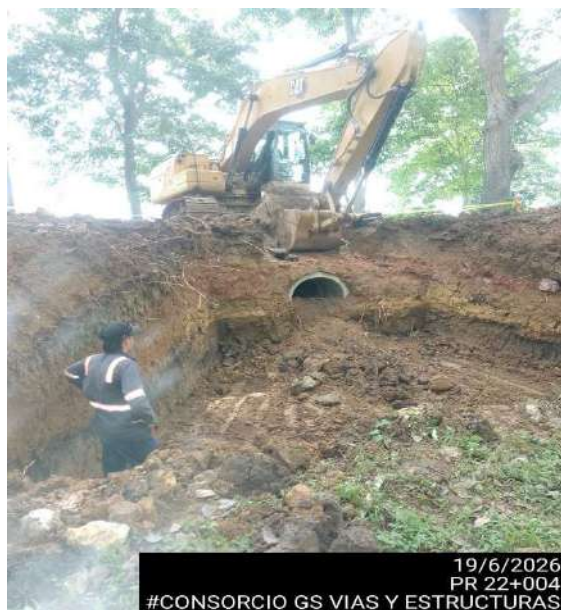
PR22+040 19 DE JUN 2026 EXCAVACION E INTALACION DE TUBERIA
