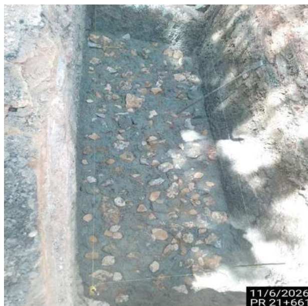
PR21+660 11 DE JUNIO 2026 CONCRETO CICLOPEO
