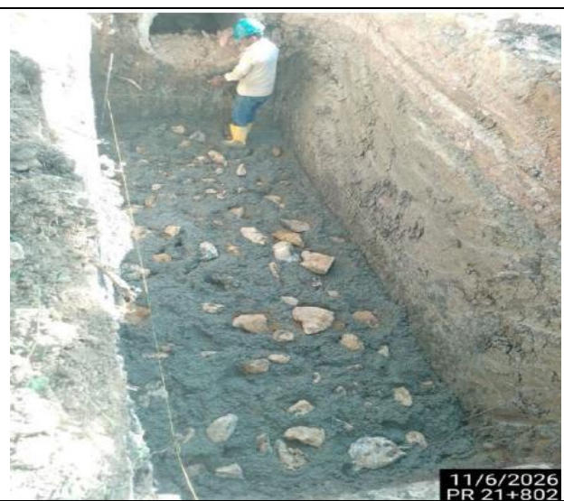
PR 21+802 CONCRETO CICLOPEO ALCANTARILLA TRAMO LORICA - CHINU
