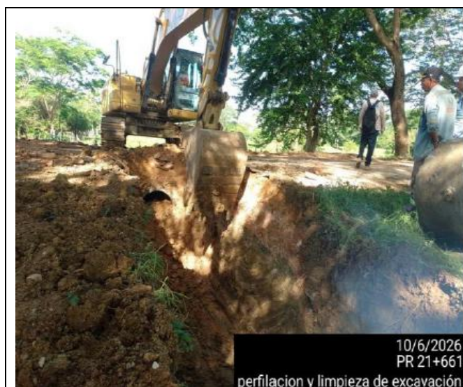
PR21+660 EXCAVACION DE ALCANTARILLA TRAMO LORICA-CHINU
