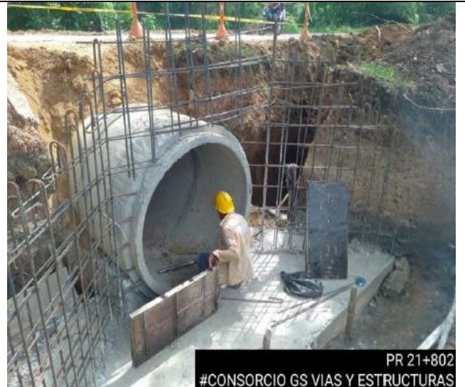
PR21+802 INSTALACIÓN DE ACERO ALCANTARILLA TRAMO LORICA – CHINU
