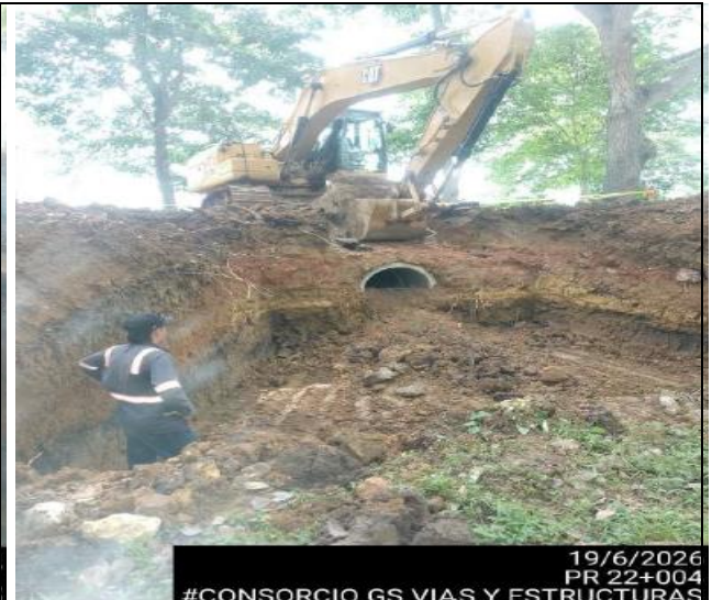
PR22+040 EXCAVACION DE ALCANTARILLA TRAMO LORICA – CHINU
