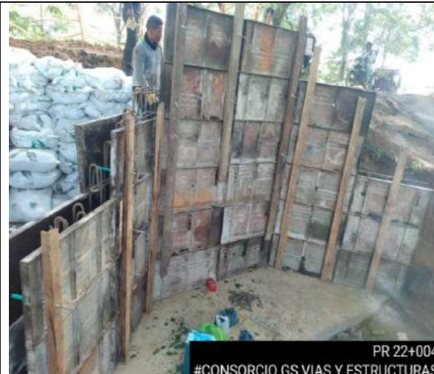
PR22+040 ENCOFRADO CABEZAL ALCANTARILLA TRAMO LORICA – CHINU
