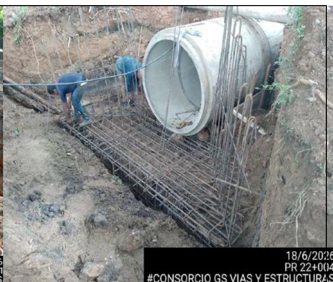
PR22+040 INTALCIÓN DE ACERO ALCANTARILLA TRAMO LORICA-CHINU
