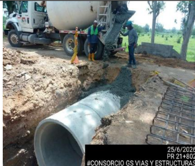
PR21+802 CONCRETO PARA ATRAQUE DE ALCANTARILLA TRAMO LORICA-CHINU
