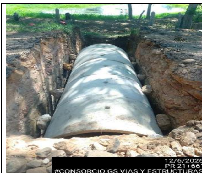
PR21+660 INSTALACIÓN DE TUBERÍA ALCANTARILLA TRAMO LORICA – CHINU
