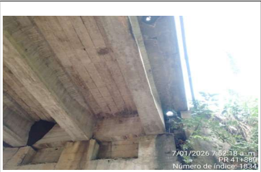
Puente Quebrada La Línea - PR41+880 - RN9008
