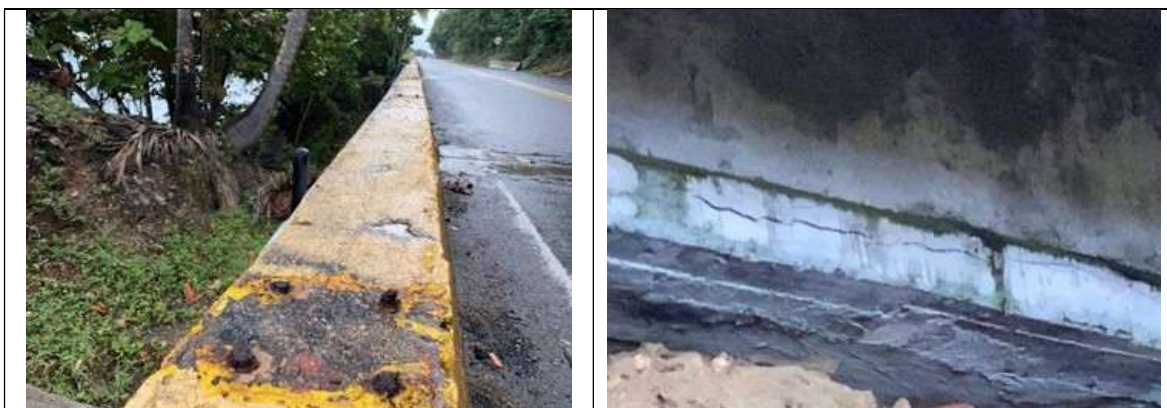
Puente Las Flores PR61+363 RN 9008
