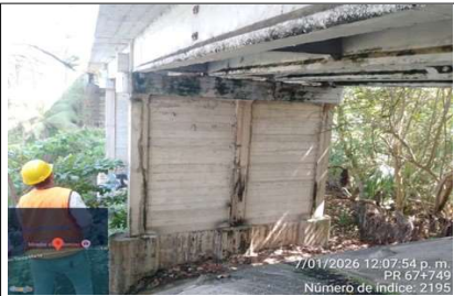
Puente Camarones - PR67+49 - RN9008
