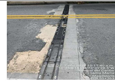
Diagnostico de estructura del Puente Las Flores II - PR61+363 (RN9008)
