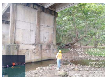
Puente Los Coquitos - PR64+763 - RN9008
