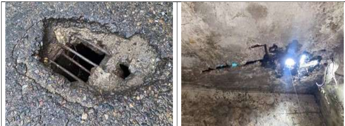
Puente Perico Aguado PR58+012 RN 9008
