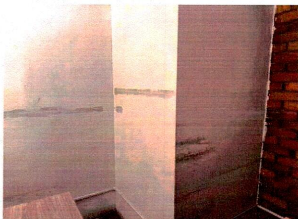
Limpieza de telarañas, polvo, resane fisuras con estuco e imperfecciones
