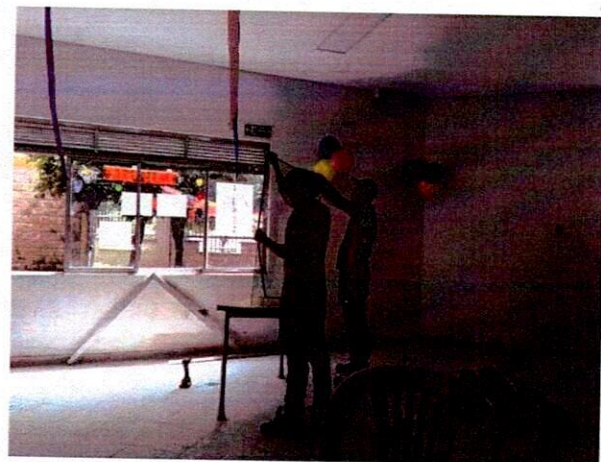
En aula Multiple sector costado occidente se desmonto vidrio roto y ventana total para efectos de poder colocar vidrio nuevo en el CDI
