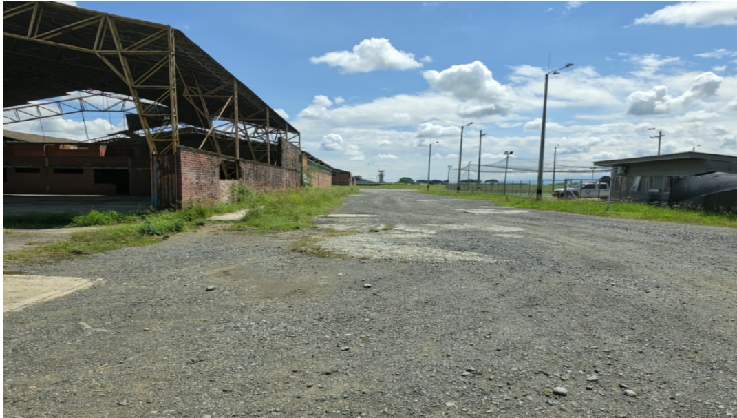
Vía V-2 mirando de cruce V-5-2 a V-4
