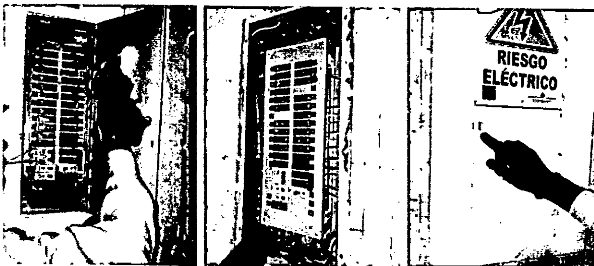
Imágenes Mantenimiento Preventivo N°6
