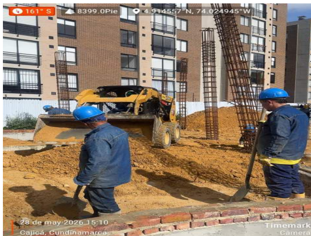
RELLENO CON BASE GRANULAR
