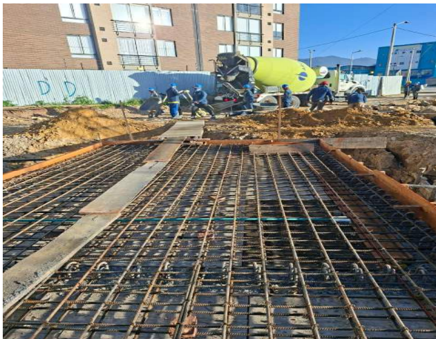
FUNDIDA DE TAPA DE TANQUE
