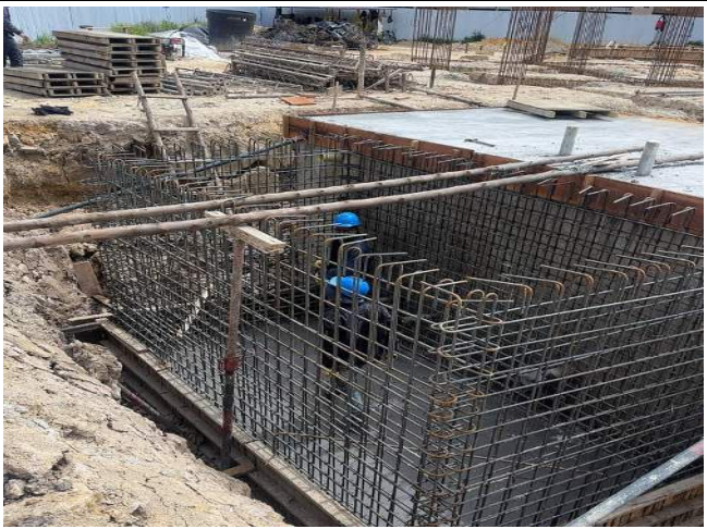
FUNDIDA DE SUELO DE CUARTO BOMBAS
