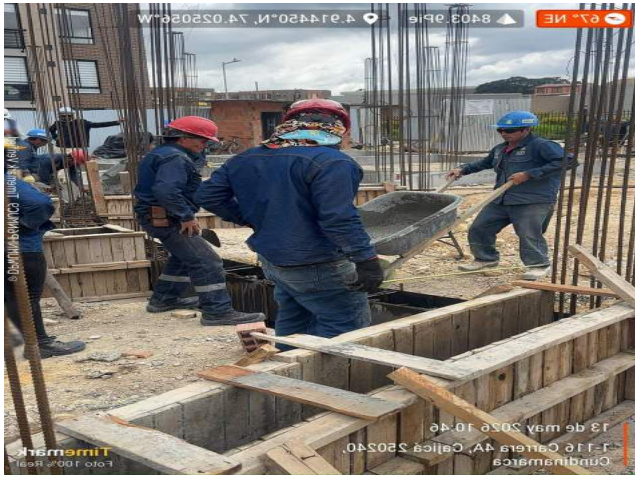
FUNDIDA DE VIGAS
