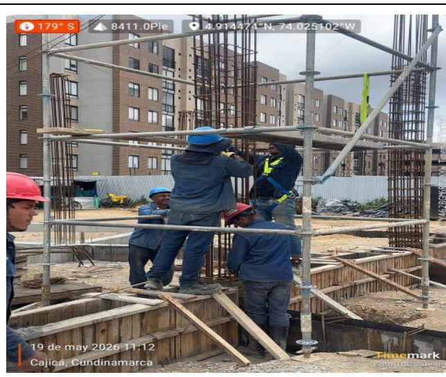
AMARRE DE COLUMNAS Y FLEJES
