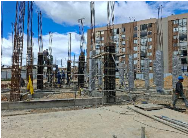
TESTERO DE COLUMNAS
