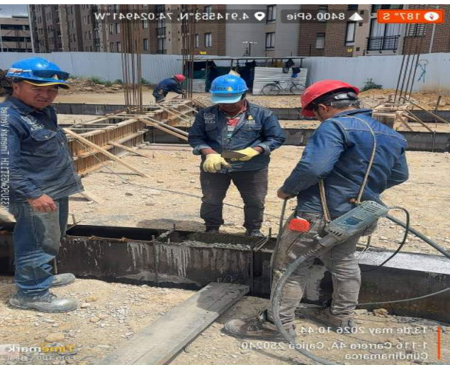
FUNDIDA DE VIGAS
