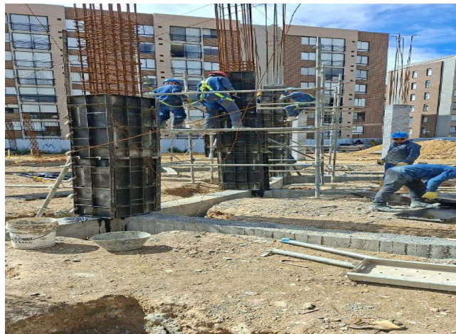
TESTERO DE COLUMNAS
