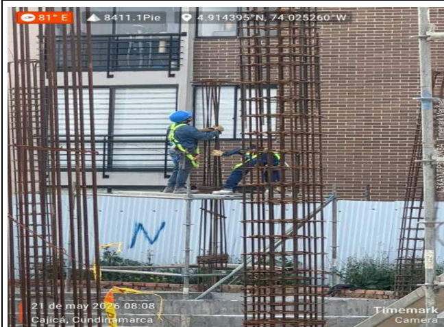
AMARRE DE COLUMNAS Y FLEJES
