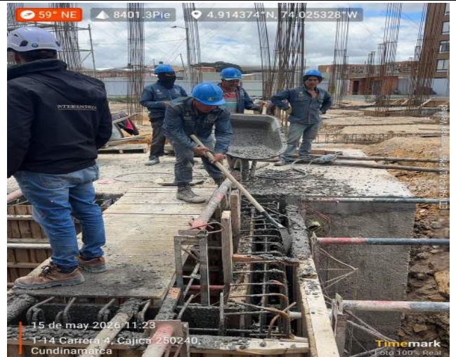
TESTERO Y FUNDIDA DE MUROS DE CUARTO B
