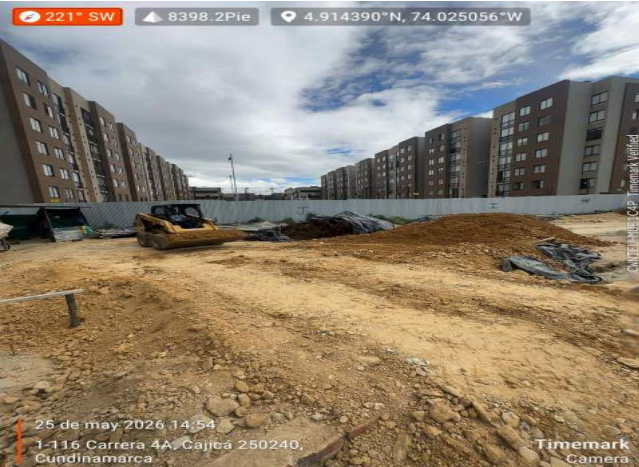
RELLENO Y COMPACTACION BASE GRANULAR
