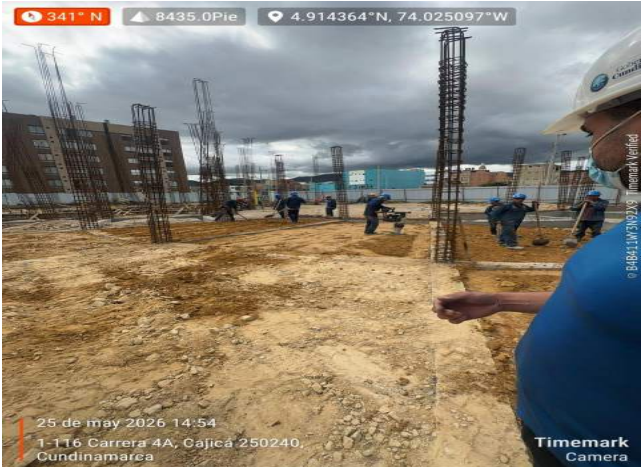
RELLENO CON BASE GRANULAR
