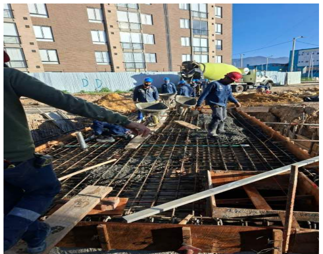
FUNDIDA DE TAPA DE TANQUE
