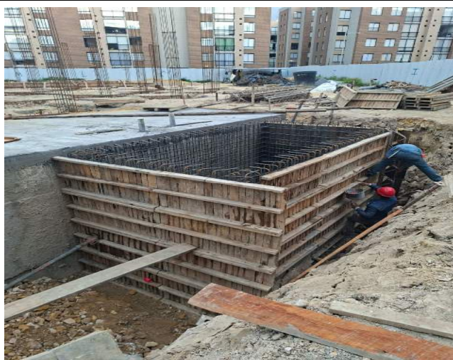
TESTERO Y FUNDIDA DE MUROS CUARTO BOMBA
