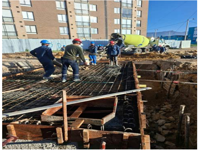
FUNDIDA DE TAPA DE TANQUE
