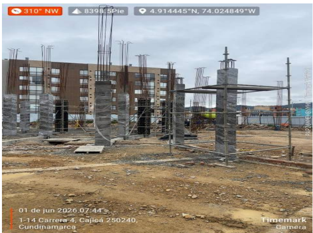
DESENCOFRADO Y FORRADO
