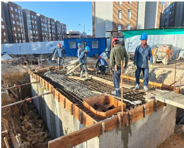
FUNDIDA DE TAPA DE TANQUE
