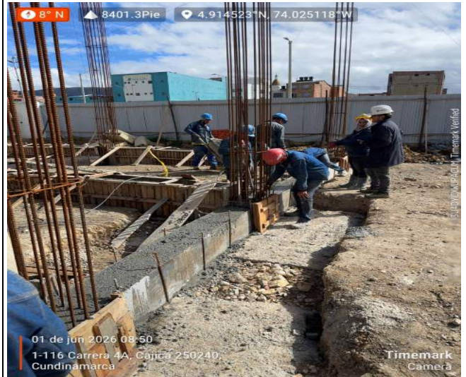
FUNDIDA DE VIGAS
