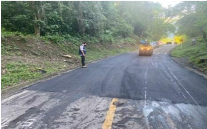
SUMINISTRO DE MEZCLA
