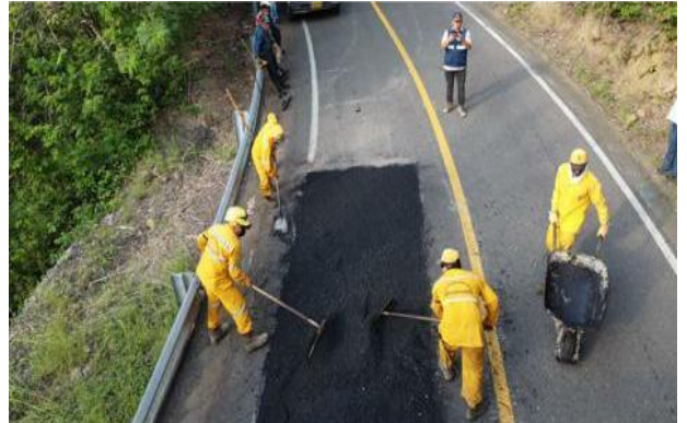
SUMINISTRO DE MEZCLA
