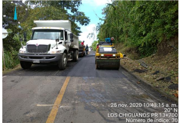
SUMINISTRO DE MEZCLA
