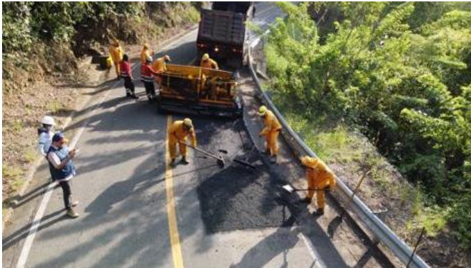
SUMINISTRO DE MEZCLA
