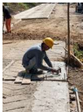
Fotografía 4: Personal operativo realizando trabajos de adecuación y acabado en la placa huella con uso adecuado de EPP.
