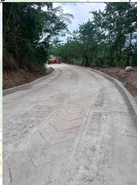
Imagen 6: PH Terminada Sector el Ceibal
