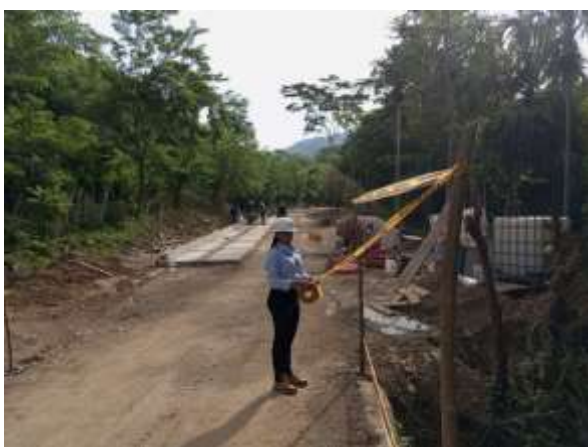
Fotografía 3: Delimitación y cerramiento preventivo del frente de obra utilizando cinta de seguridad y señalización vial.
