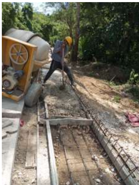
Fotografía 10: Vaciado y extendido de concreto con pala directamente desde la mezcladora sobre el acero de refuerzo.
