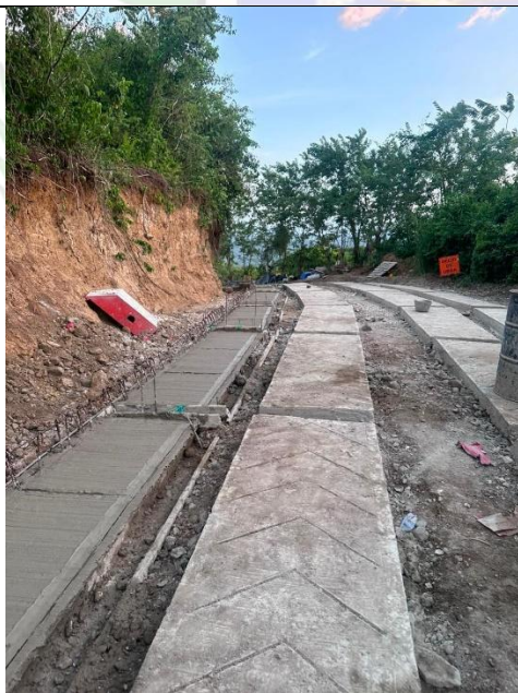
Imagen 9: Fundida de Huella y cuneta
