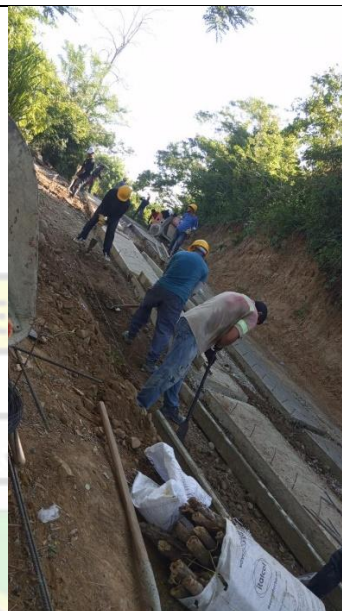
Imagen 12: Excavación de Bordillo
