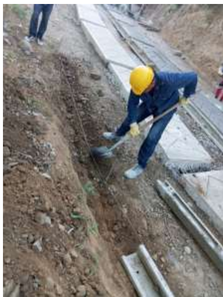
Fotografía 11: Operario realizando conformación y nivelación de terreno con pala previo al vaciado de concreto.
