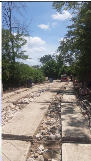
Imagen 11: Acero de vigas
