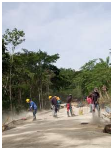
Fotografía 12: Personal operativo realizando retiro de material particulado y escombros previo al avance de obra.
