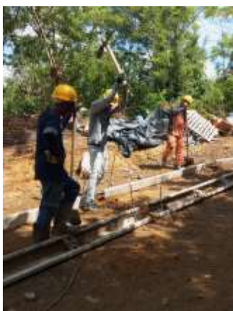
Fotografía 5: Labores manuales de excavación y perfilado de bordes respetando normas de postura e higiene ocupacional.
