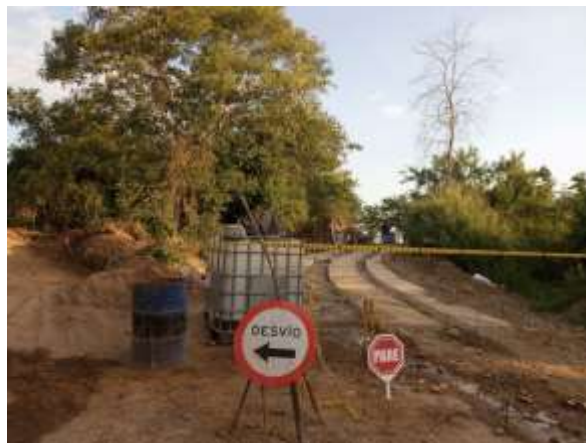
Fotografía 8: Evidencia de la correcta señalización vial preventiva (valla de desvío y Pare) y control de tránsito en el área de trabajo.
