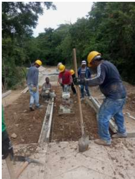
Fotografía 9: Compactación de afirmado/subrasante con rana compactadora en tramo central de placa huella
