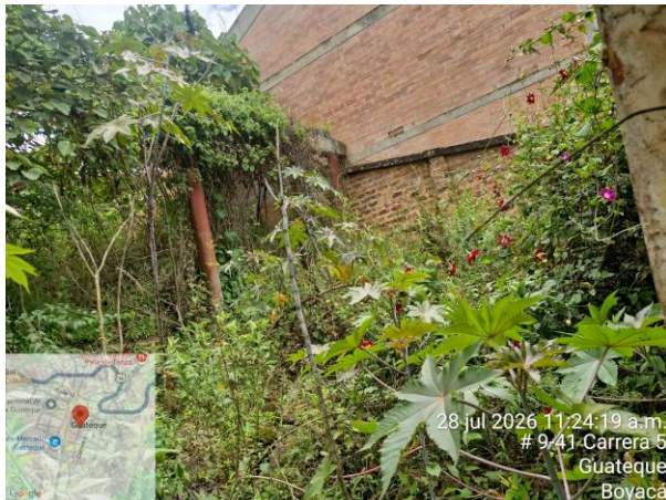
VISTA INTERNA COSTADO OCCIDENTAL
