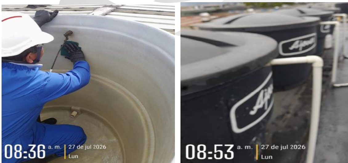
Imagen 5 – 6 Evidencia Lavado de Tanques
