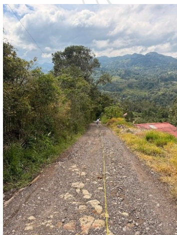
Punto inicial K7+511 ( 74^{\circ}14'32.04''W 5^{\circ}0'6.57''N ) Tramo sin obras de drenaje, con una pendiente aproximada de 5.5%.
