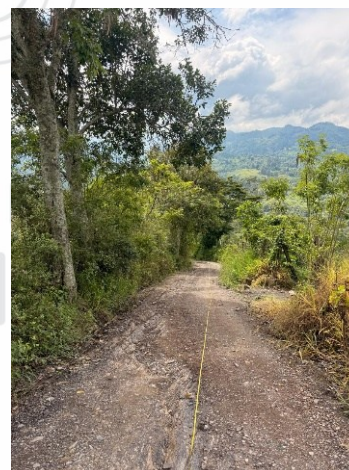
Punto intermedio K7+551 74^{\circ}14'30.84''O 5^{\circ}0'6.63''N , tramo sin obras de arte con poco recebo difícil acceso
