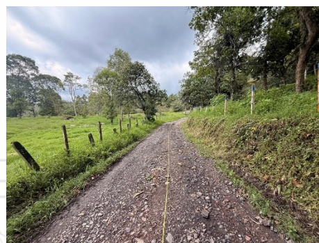
Punto intermedio K2+636 74^{\circ}16'21.66''O 4^{\circ}59'24.43''N , tramo sin obras de arte con poco recebo difícil acceso
