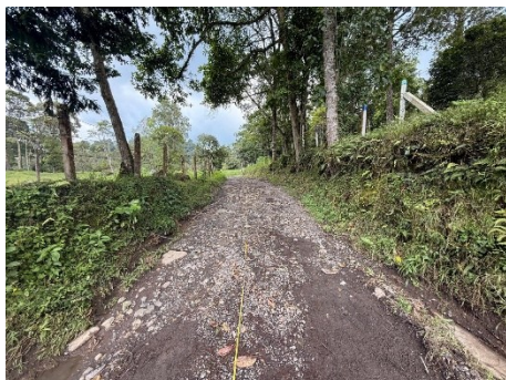
Punto inicial K2+596 ( 74^{\circ}16'22.10''W 4^{\circ}59'23.20''N ) Tramo sin obras de drenaje, con una pendiente aproximada de 5.5%.
