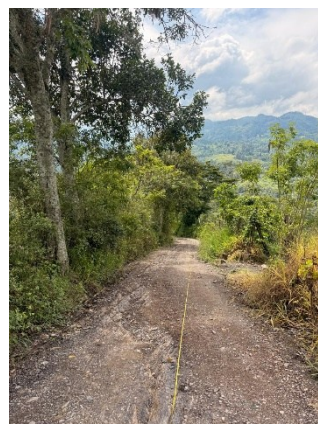
Punto intermedio K7+551 74^{\circ}14'30.84''\text{O} 5^{\circ}0'6.63''\text{N} , tramo sin obras de arte con poco recebo difícil acceso
