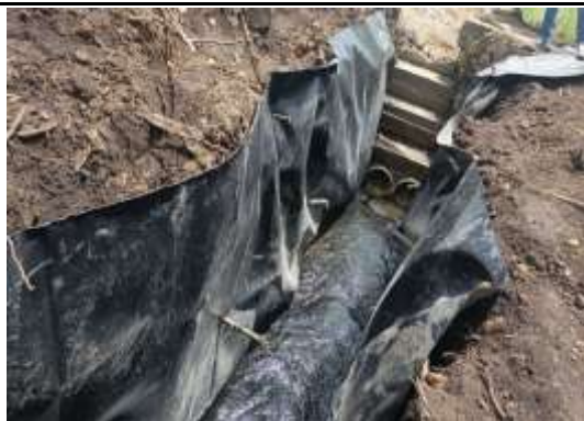
Fotografía N°7. Verificación de protección de cuerpo de agua - Corinto
