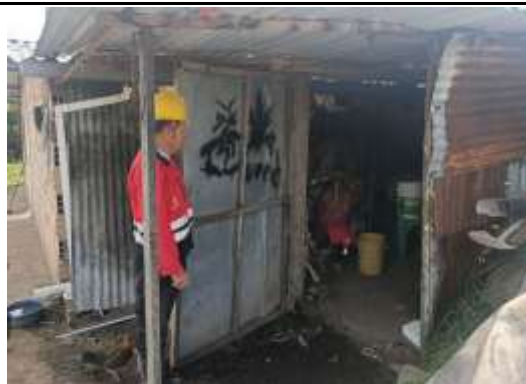
Fotografía N°8. Verificación de campamento temporal
