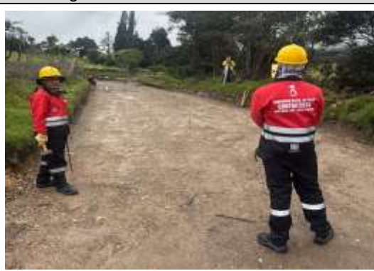
Fotografía N°12. Verificación de uso de dotación y EPP en obra
