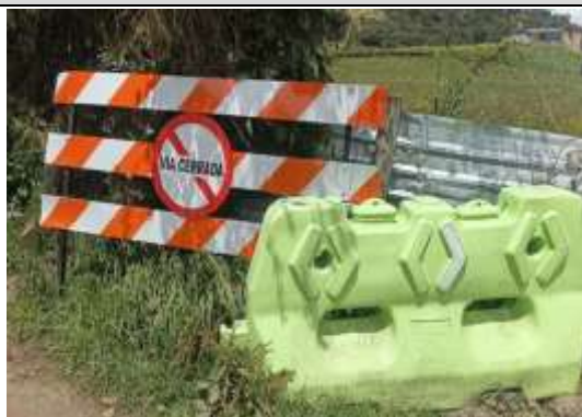
Fotografía N°11. Recorrido de verificación de señalización en obra
