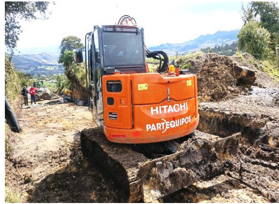
Fotografía N°4. Verificación de maquinaria en obra.
