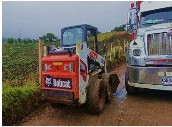
Fotografía N°3. Verificación de volquetas en obra.
