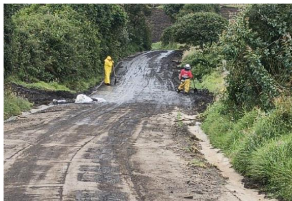
Fotografía N°6. Verificación de limpieza en vías adyacentes a obra.
