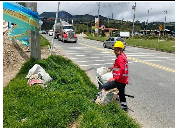
Fotografía N°14. Verificación de orden y aseo en obra
