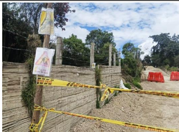
Fotografía N°11. Recorrido de verificación de señalización preventiva en obra
