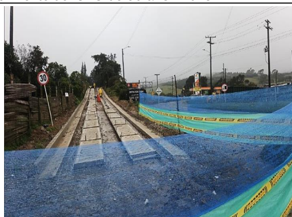
Fotografía N°2. Verificación de cerramiento de segmento en intervención - Soches
