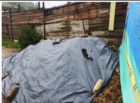
Fotografía N°13. Verificación de protección de acopios en obra.
