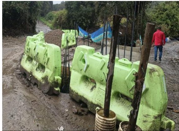
Fotografía N°9. Verificación de delimitación de obra
