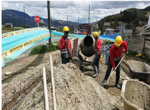
Fotografía N°5. Recorrido de verificación de actividades en obra.
