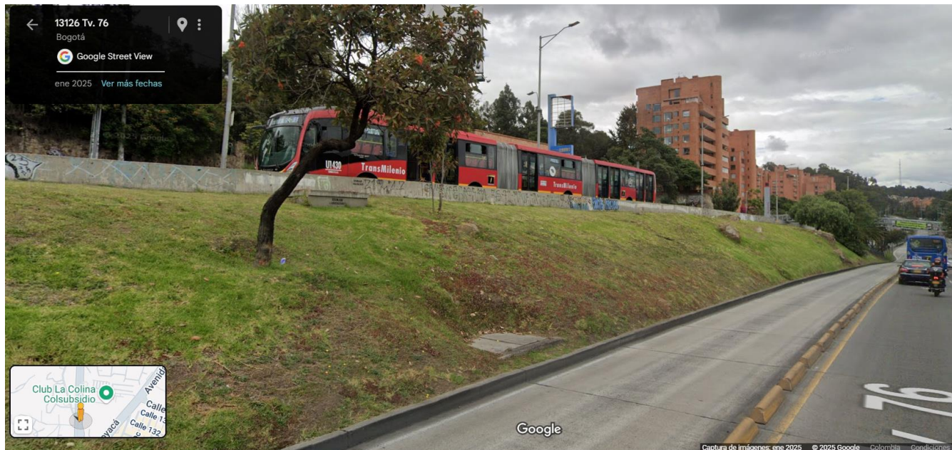
Ilustración 13: Panorama de la troncal Suba a la altura de la estación Gratamira
