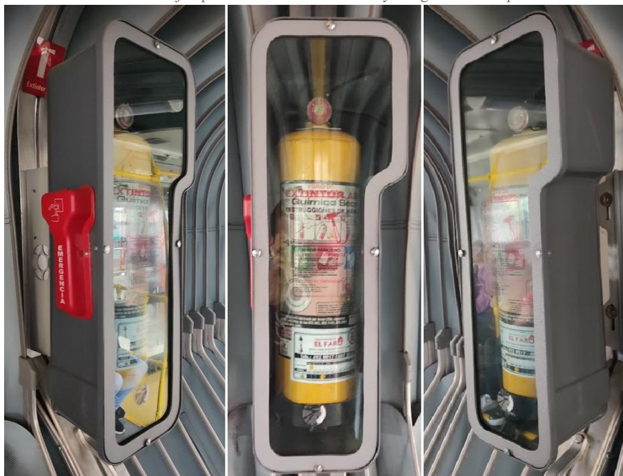
Ilustración 100: Ejemplo de extintores de cabina y sus gabinetes de protección
