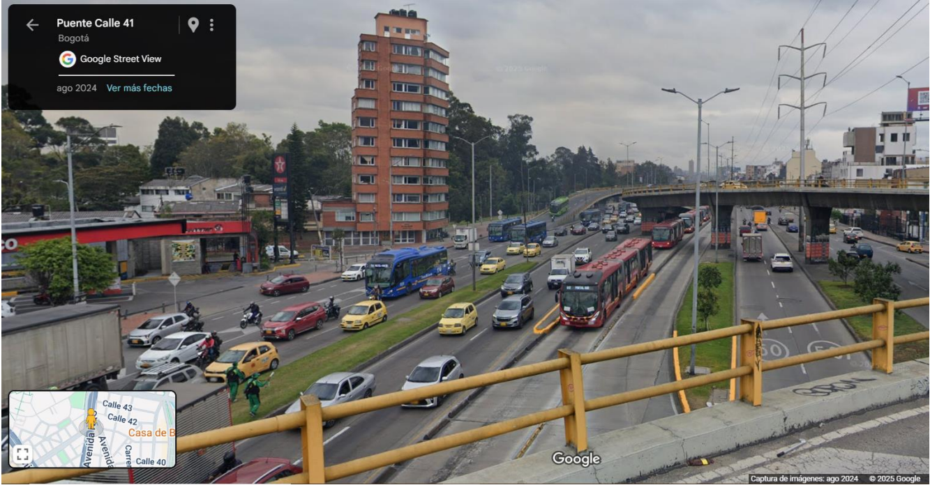
Ilustración 16: Panorama de la troncal NQS central a la altura de Carrera 33
