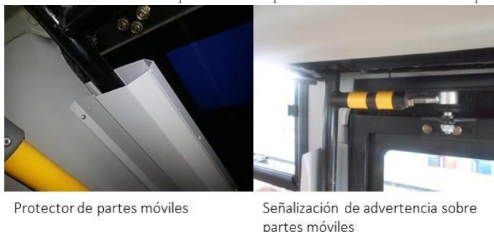
Ilustración 76: Elementos de protección de piezas móviles del sistema de puertas
