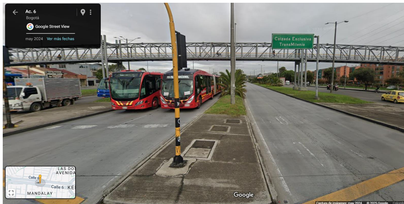
Ilustración 14: Panorama de la troncal Américas a la altura de la estación Banderas
