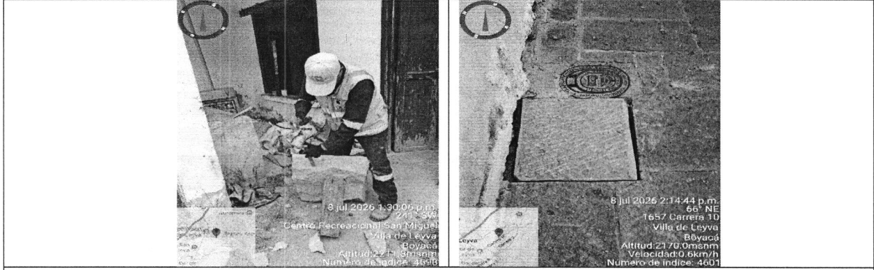
Fotografías 15-16. Reajuste, reposición e instalación de piedra labor sobre la cinta peatonal de la Carrera 9ª, en el sector aledaño a la Sede Principal de ITINAR.
