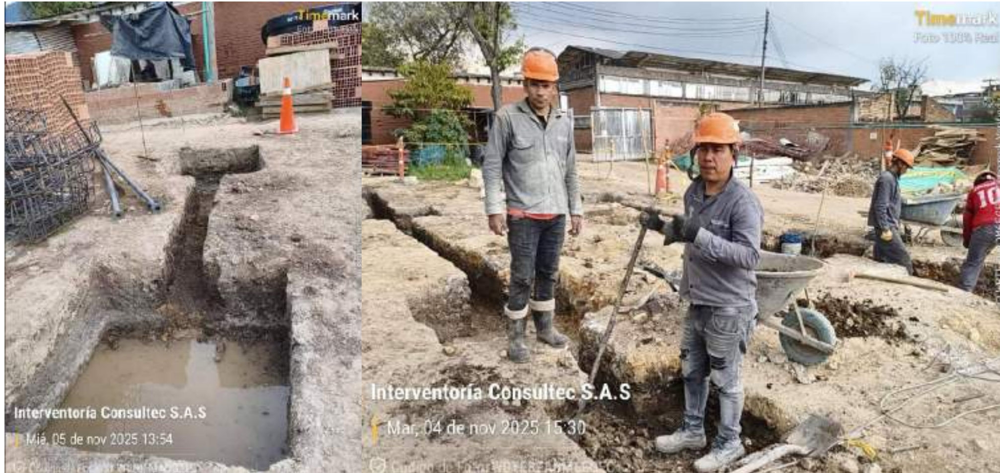
Excavación zapatas y vigas de cimentación mejoramiento base portante - Bloque 3.
