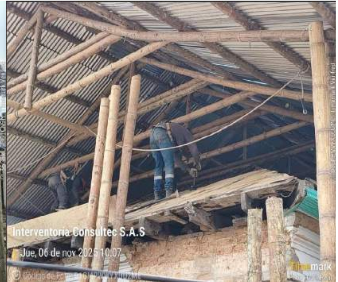
Desmonte de tablón de manto de cubierta - Bloque 1.
