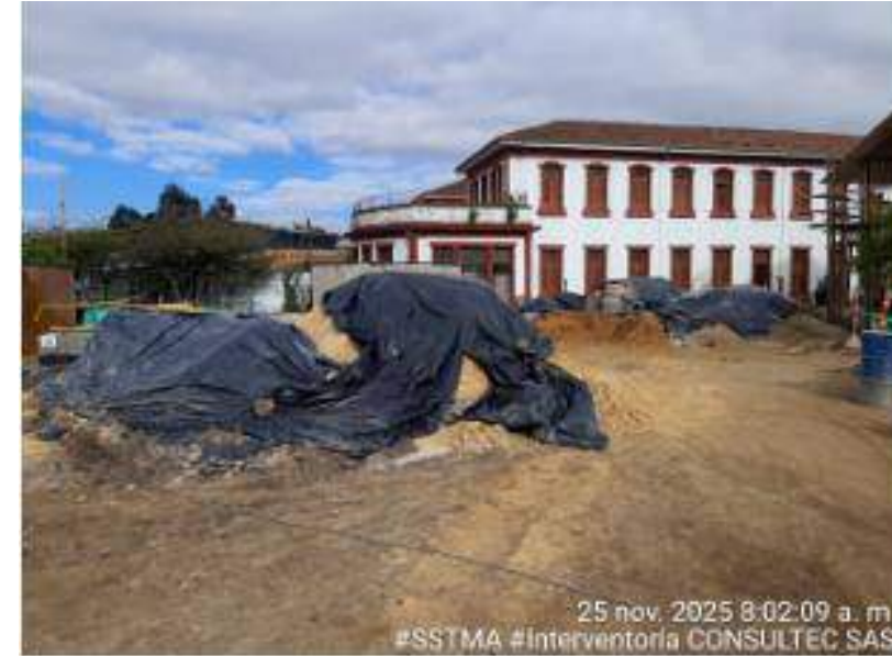
Protección de materiales granulares
