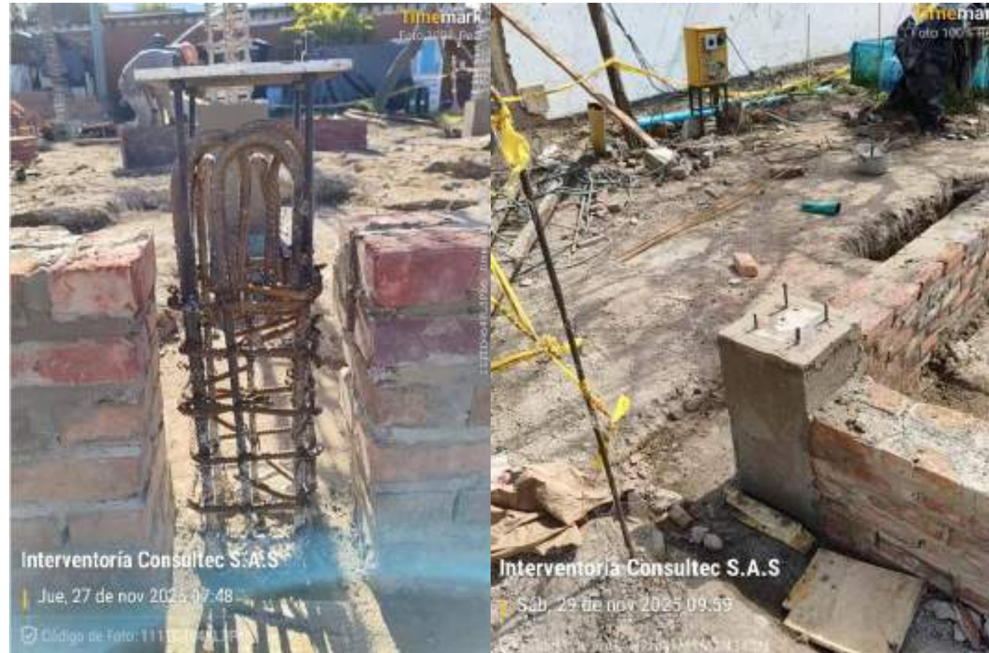
Armado y vaciado de pedestales eje A"- Bloque 3.
