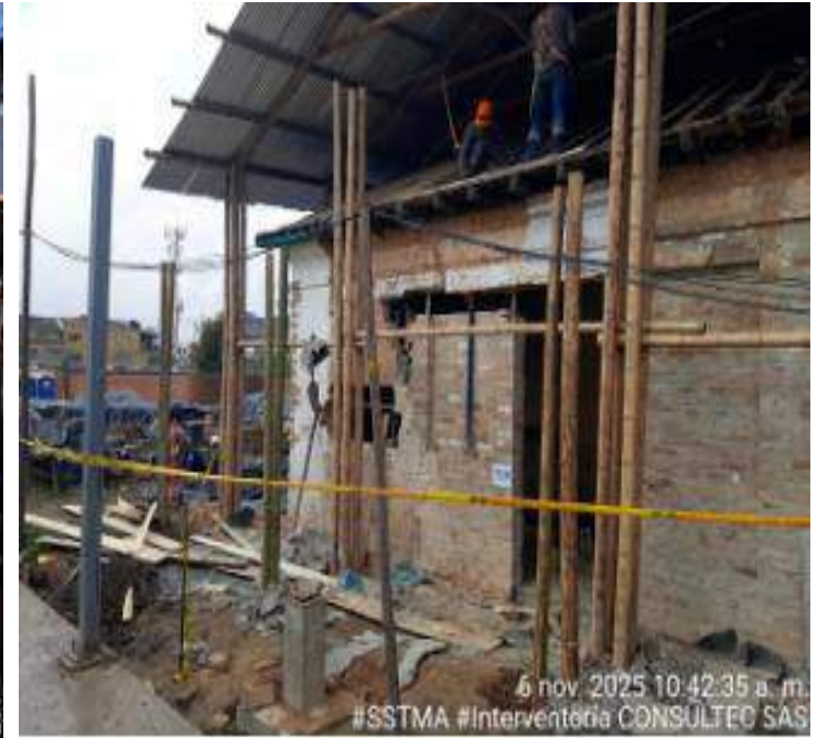
Señalización de áreas para trabajos en alturas
