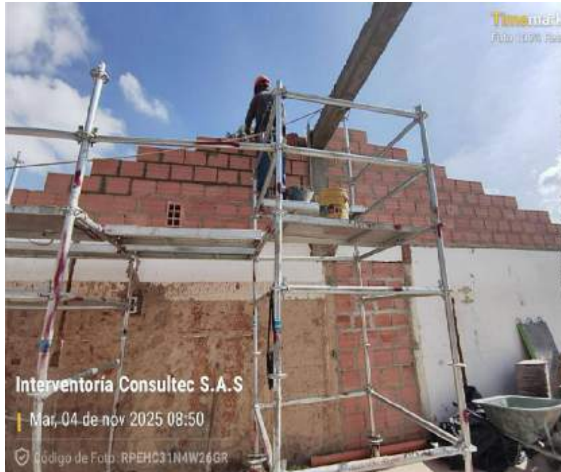
Mampostería muros internos - Bloque 2.
