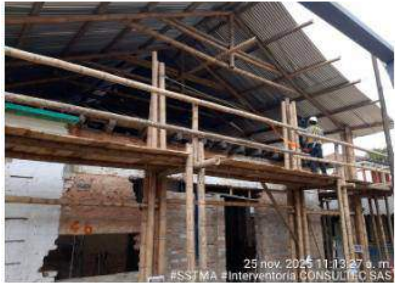
Supervisión de trabajos en alturas
