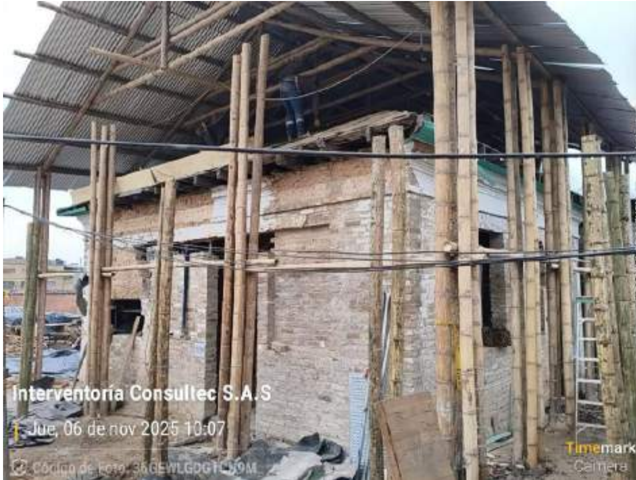
Desmonte de tablón de manto de cubierta - Bloque 1.
