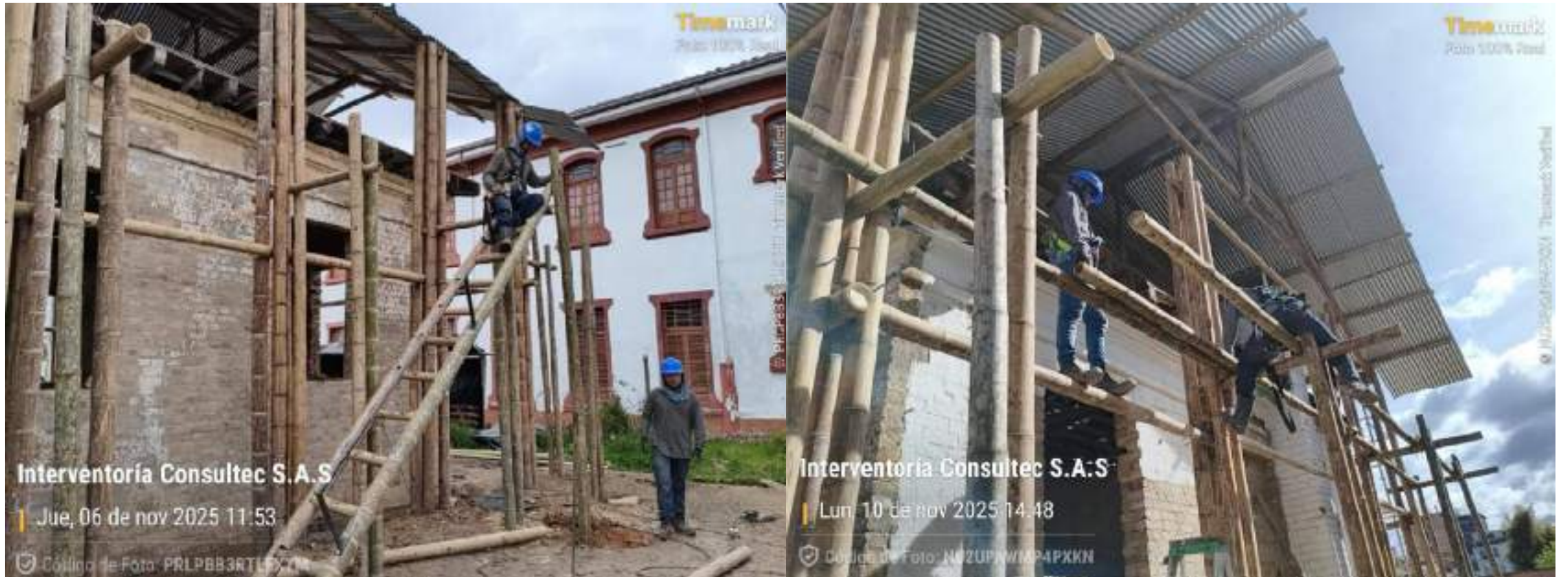
Construcción pasarela - Bloque 1.
