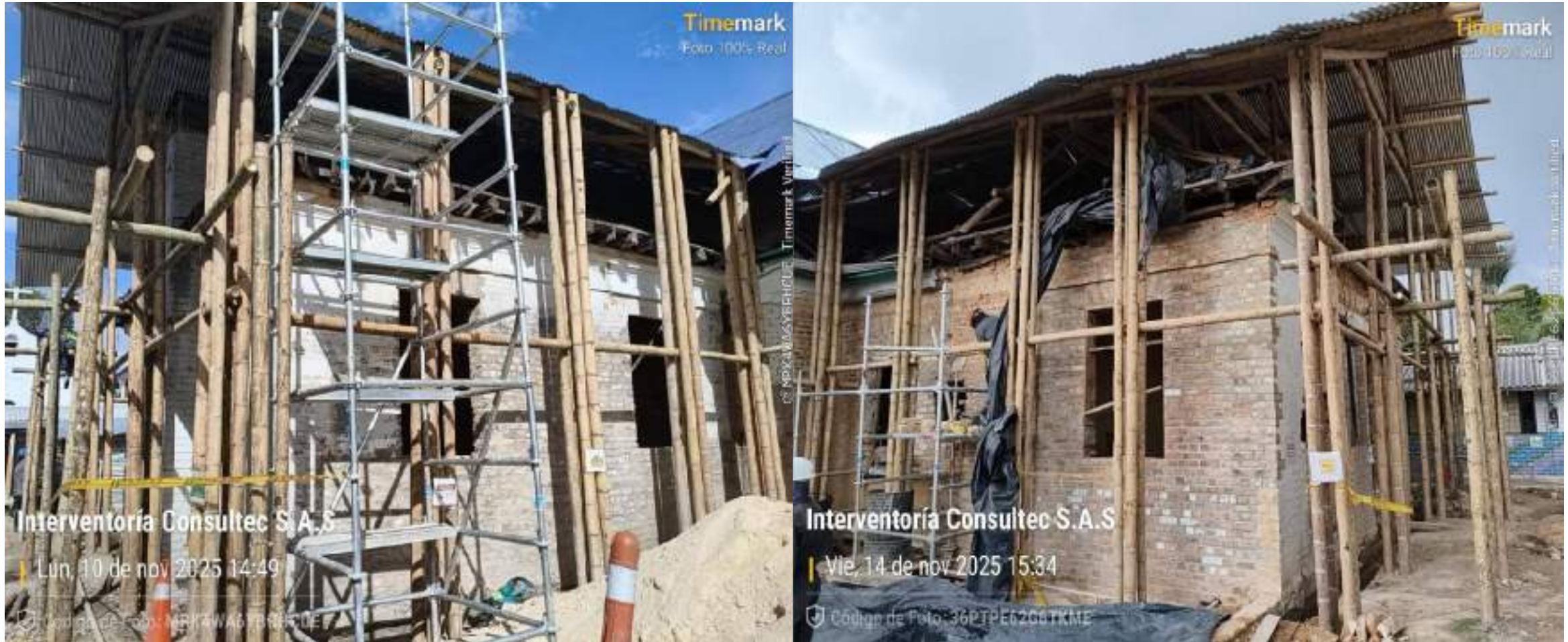
Construcción pasarela - Bloque 1.
