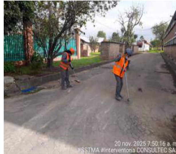
Limpieza de vía
