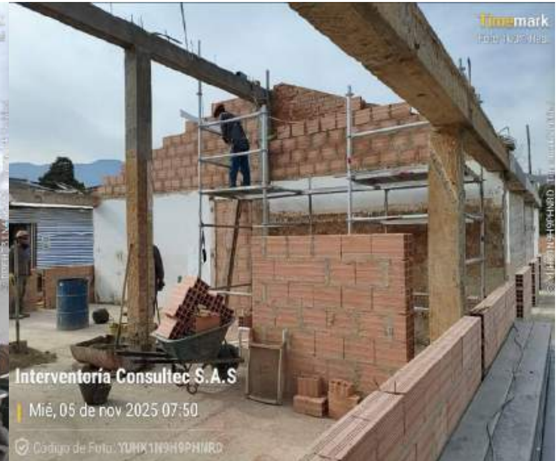
Mampostería muros internos - Bloque 2.
