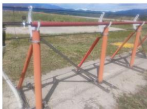
ANTENA DE CLEARANCE
