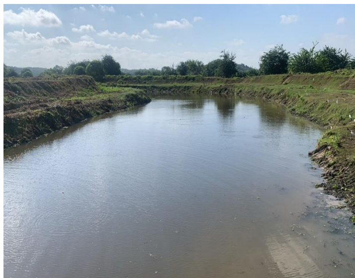
Estado después de la Limpieza
