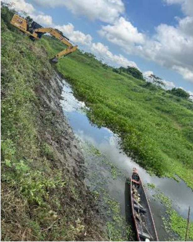
Actividades de Limpieza Mecánica
