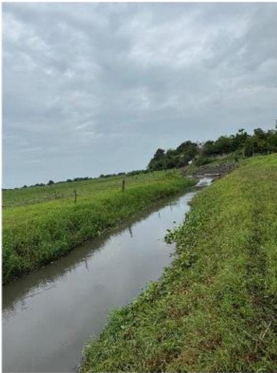
Estado después de la Limpieza
