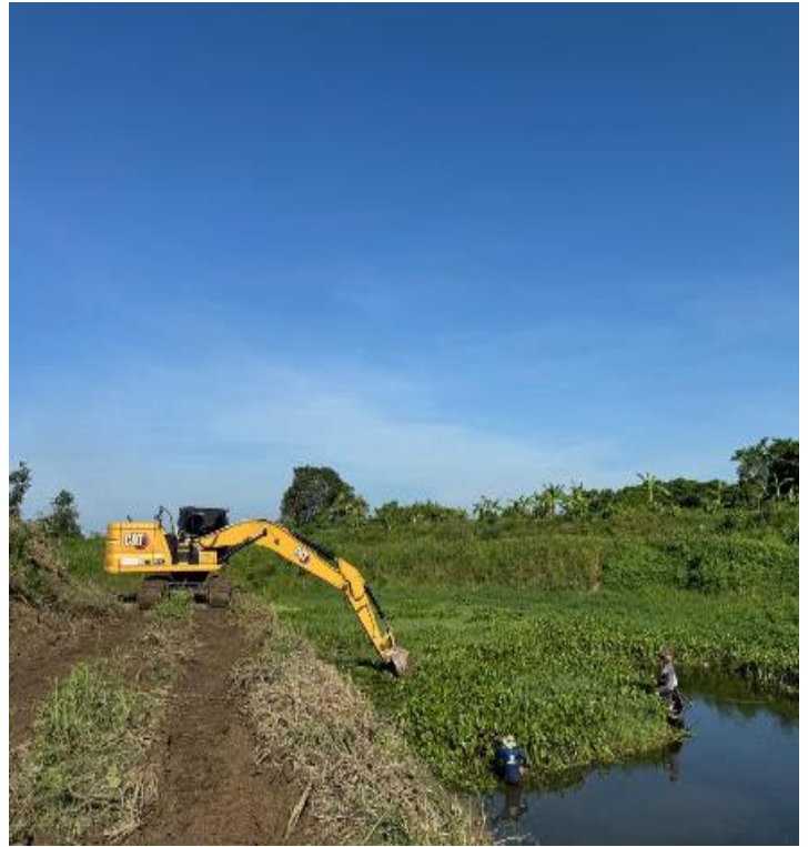
Actividades de Limpieza Mecánica
