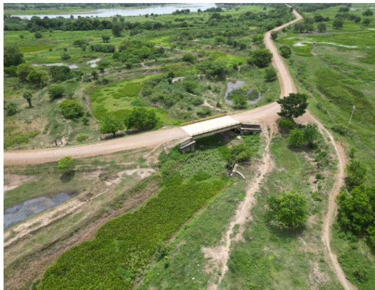
Estado inicial Caño Real del Obispo
