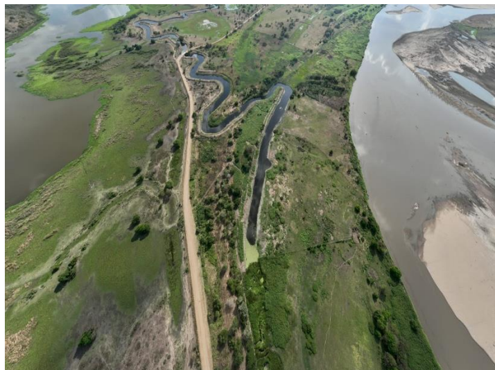
Estado después de la Limpieza
