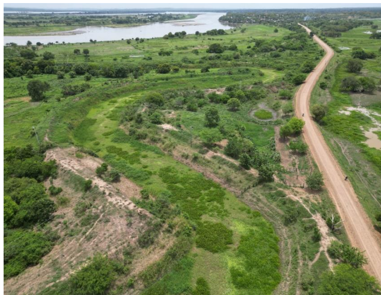
Estado inicial Caño Real del Obispo
