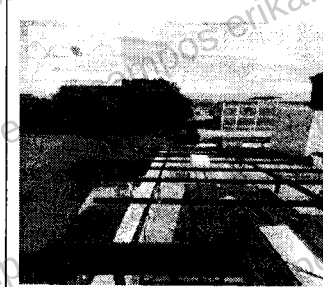
Suministro e Instalación de manto autoprotegido con foil aluminio y alma central de polietileno de alta densidad de calibre igual o superior 3mm
