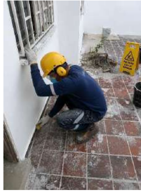
Actividades en obra
