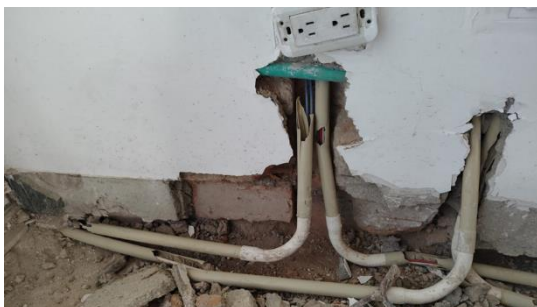
Desmonte puntos eléctricos
