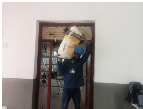
Acarreo interno de escombros
