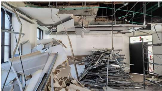
Desmonte cielo falso
