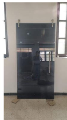
Desmonte puerta muro divisorio
