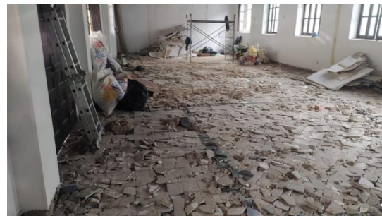
Demolición de piso
