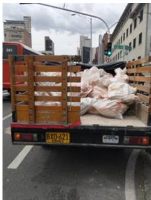
Botada de escombros
