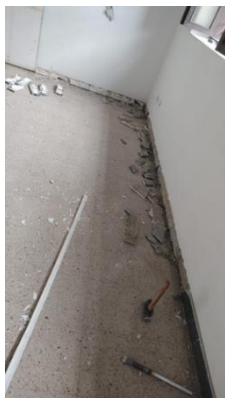
Demolición de zócalos
