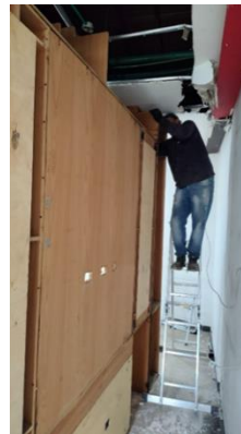
Desmonte muebles de madera
