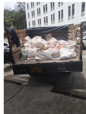
Botada de escombros
