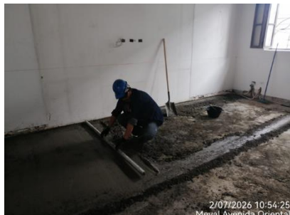
Vaciado mortero de nivelación
