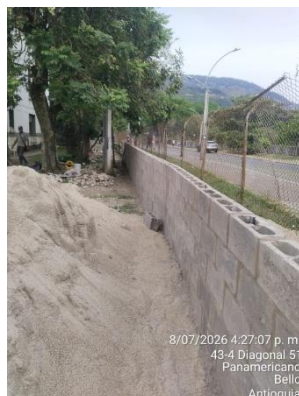
Construcción de muro de cerramiento
