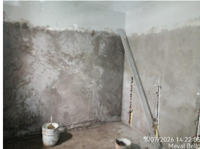
Revoque de muros
