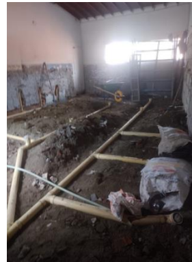
Se realiza excavación en búsqueda de tubería sanitaria existente
