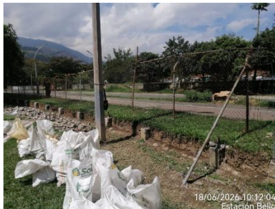
Desmonte de cerramiento y traslado a metro y medio
