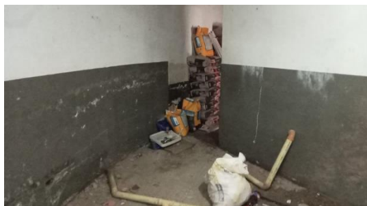
Extracción de tubería existente
