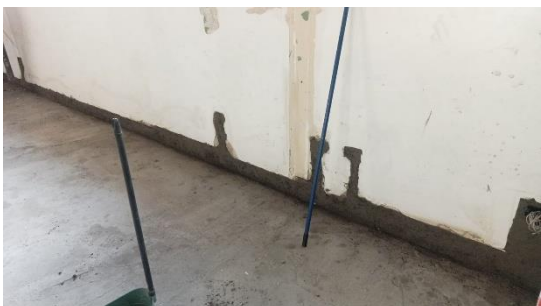
Revoque en muro donde se instaló tubería eléctrica
