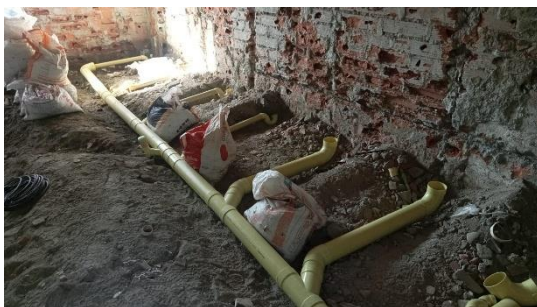
Instalación de tubería sanitaria
