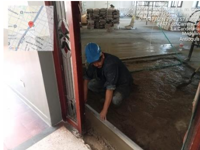
Vaciado mortero de nivelación
