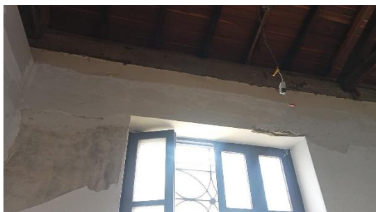
Desbaste de estuco mal estado
