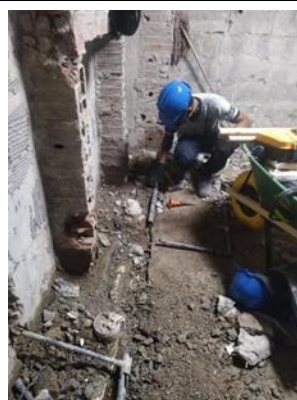
Excavación en búsqueda de tubería sanitaria
