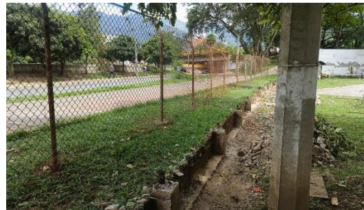
Desmonte de cerramiento y traslado a metro y medio
