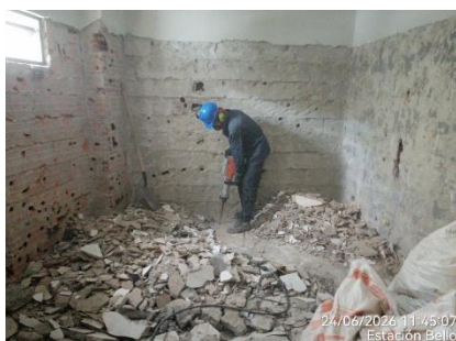
Demolición de enchape de muros y piso
