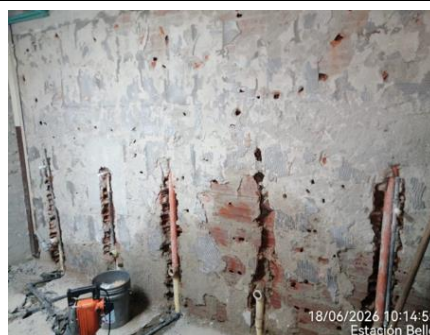
Búsqueda tubería sanitaria existente
