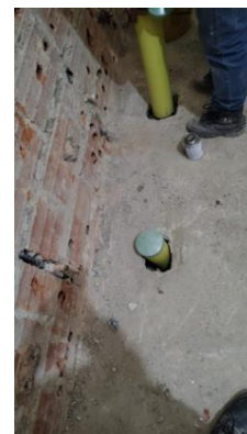
Trabajos de plomería tubería sanitaria
