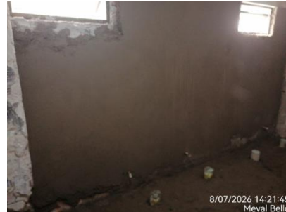
Revoque de muros
