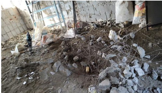
Demolición de piso baños hombres piso 2
