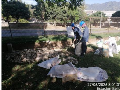
Empacada de escombros en costales
