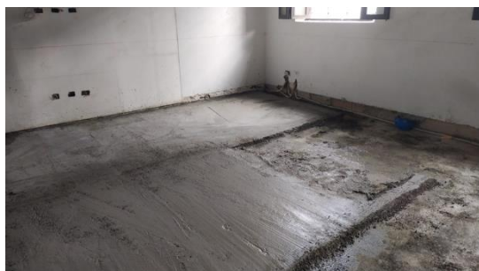
Vaciado mortero de nivelación
