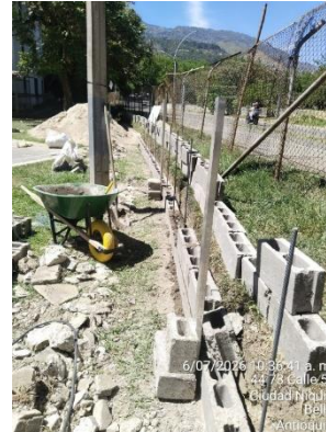
Construcción de muro de cerramiento
