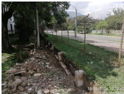
Desmonte de cerramiento y traslado a metro y medio
