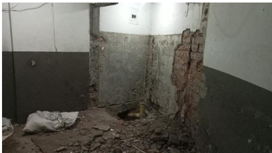
Excavación de tubería existente
