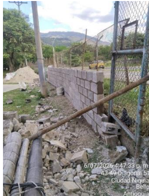
Construcción de muro de cerramiento
