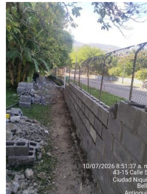
Construcción de muro de cerramiento
