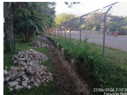
Desmonte de cerramiento y traslado a metro y medio
