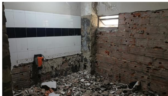
Demolición de enchape de muros y piso
