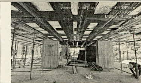
DESCRIPCIÓN: Avance ejecución Bloque Aulas P4
