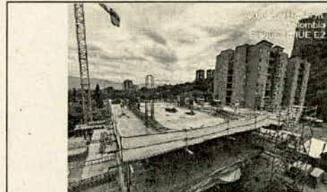
DESCRIPCIÓN: Avance ejecución Bloque de Biblioteca P5
