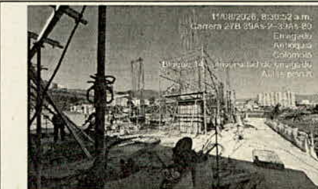
DESCRIPCIÓN: Avance ejecución Bloque Aulas P6
