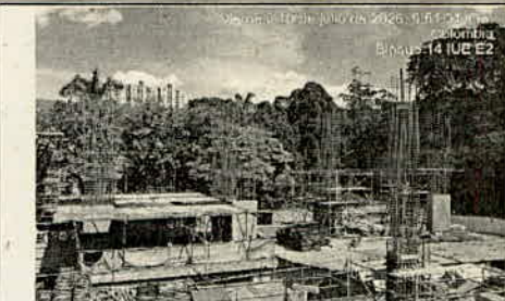
DESCRIPCIÓN: Avance ejecución Bloque de Ascensores P3
