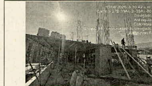
DESCRIPCIÓN: Avance ejecución Bloque Aulas P6 y montaje losa P7
