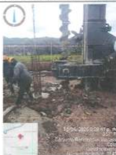
Descripción: Instalación de acero de refuerzo para pilotes de cimentación de la EBAR – Alcantarillado de Parcelas
