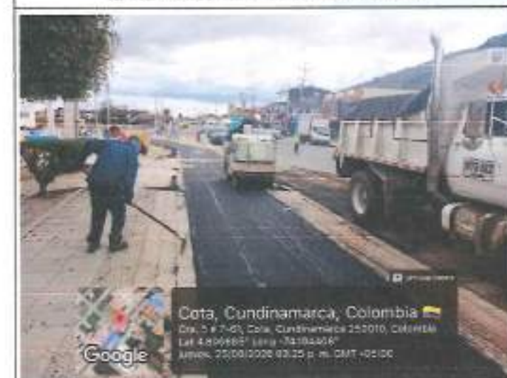
Descripción: Instalación de asfalto de cicloruta Tramo 3 (tubería 16 PVC) – Conducción Agua Potable
