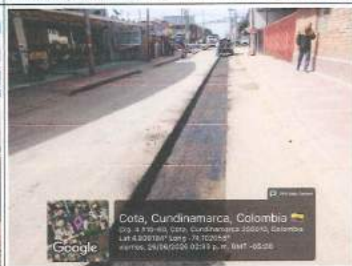
Descripción: Imprímación para asfalto de la vía Tramo 3 (tubería 16 PVC) – Conducción Agua Potable
