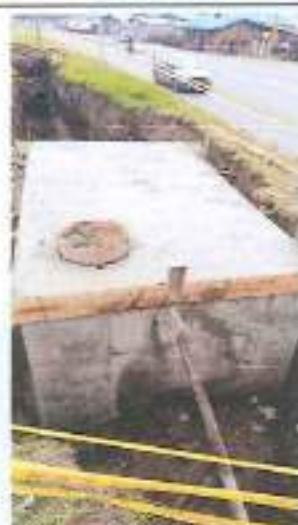
Descripción: Construcción de Caja Válvula de 20" (Sector Carulla Tramo I) – Conducción Agua Potable.
