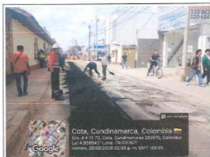
Descripción: Instalación de asfalto de la vía Tramo 3 (tubería 16 PVC) – Conducción Agua Potable
