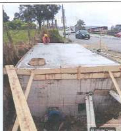
Descripción: Construcción de Caja Válvula de 20" (Sector Refous Tramo I) – Conducción Agua Potable.
