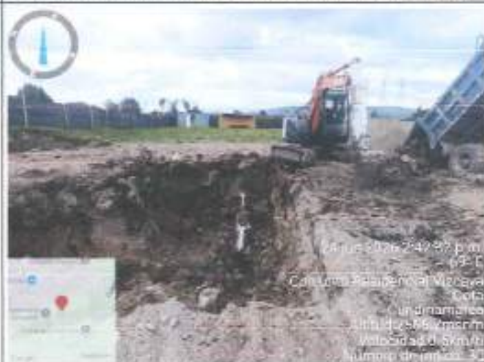
Descripción: Excavación para construcción de estructuras de la EBAR – Alcantarillado de Parcelas
