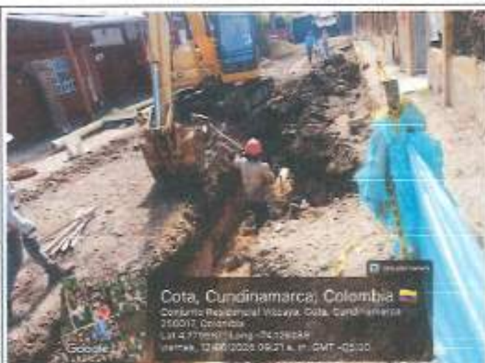
Descripción: Instalación de triturado para cama de asiento de la tubería 8" PVC – Alcantarillado Parcelas
