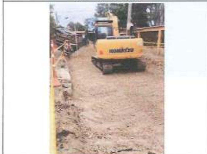
Descripción: Instalación de subbase granular para estructura de la vía – Vía Parcelas
