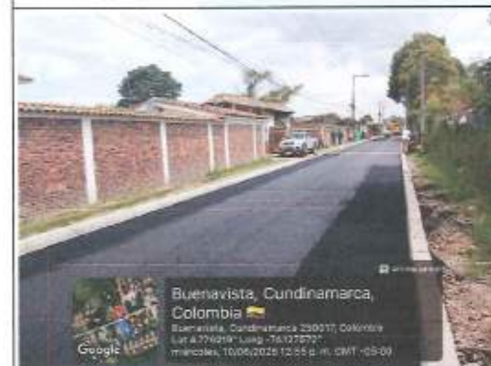
Descripción: Instalación de asfalto para estructura de la vía – Alcantarillado Vía Parcelas.
