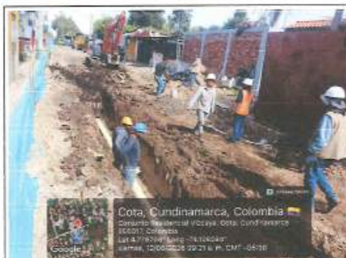
Descripción: Instalación de tubería 8" PVC – Alcantarillado Parcelas
