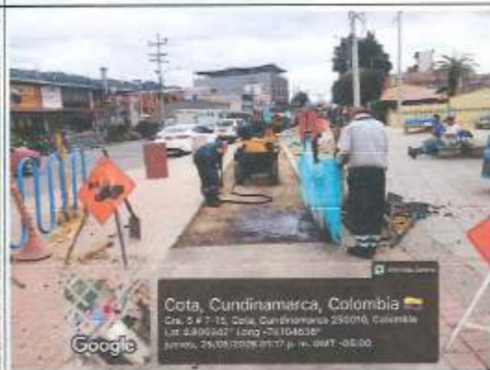
Descripción: Imprímación par asfalto de cicloruta Tramo 3 (tubería 16 PVC) – Conducción Agua Potable
