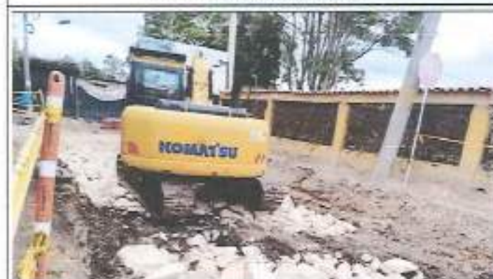
Descripción: Instalación de rajón para estructura de la vía – Vía Parcelas
