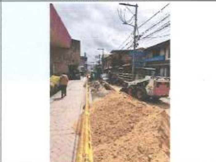
Descripción: Excavación para instalación de tubería 16" PVC (Tramo 3) – Conducción Agua Potable
