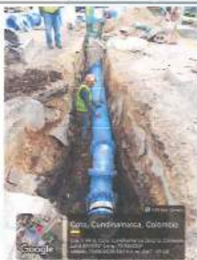
Descripción: Instalación de accesorios HD para tubería de 16" PVC (Tramo 3) – Conducción Agua Potable
