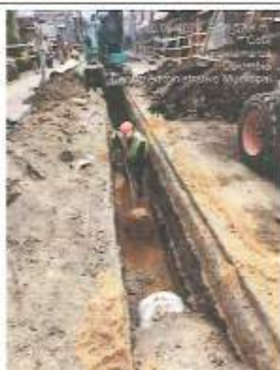
Descripción: Instalación de tubería y cama de asiento para la tubería de 16" PVC (Tramo 3) – Conducción Agua Potable
