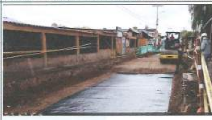
Descripción: Instalación de geotextil para estructura de la vía – Vía Parcelas
