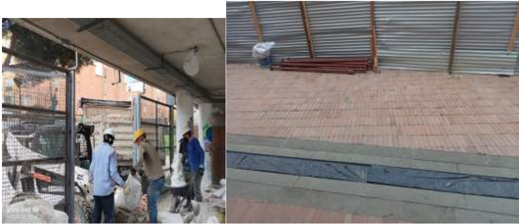
Ilustración 10 – Registro fotográfico del campamento aseado y su señalización correspondiente
