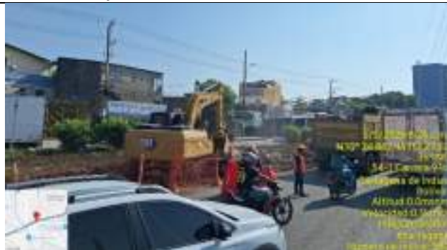
Imagen 10. Levantamiento de andenes y bordillo en punto de empalme de la via existente de territorio mio con la ejecutada
