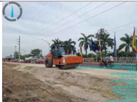
Imagen 9. Compactacion de material seleccionado para carril temporal en sentido Amparo – El pozon
