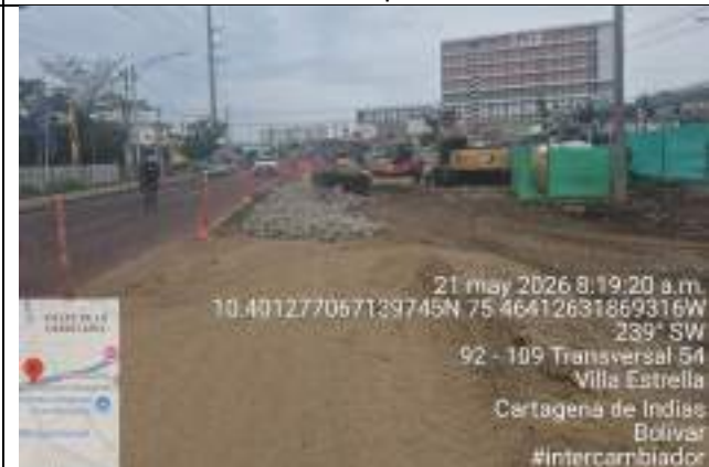
Imagen 4. Demolicion de andenes y relleno con material seleccionados en separador
