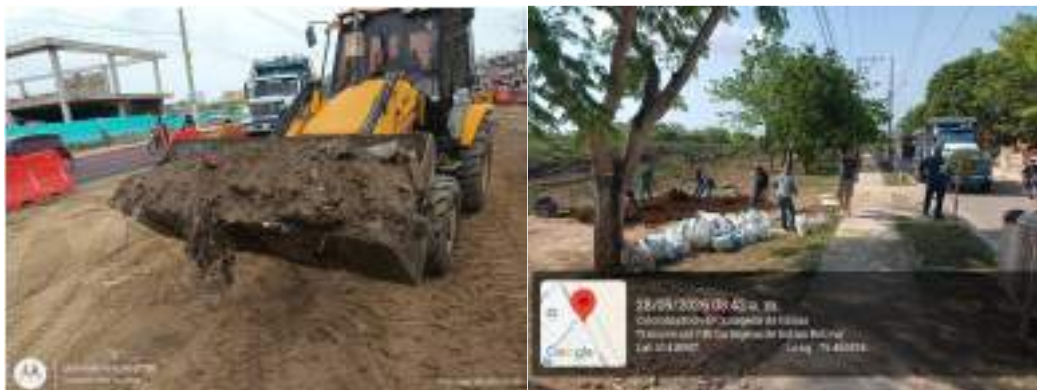
Ilustración: Aprovechamiento RCD y donación de material es espacio público – actividades de excavación
