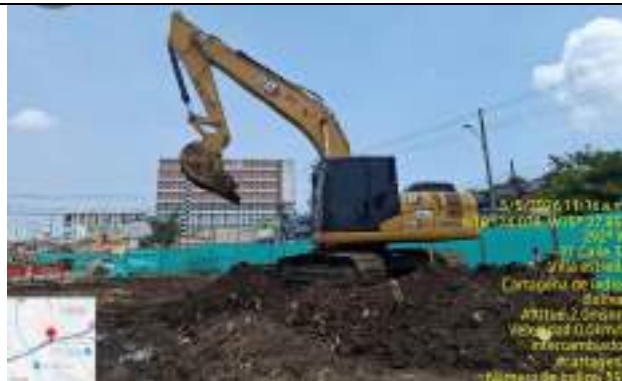
Imagen 6. Retiro de escombros del separador
