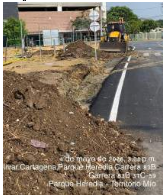
Imagen 13. Descarga de material para nivelar el hombro de la via
