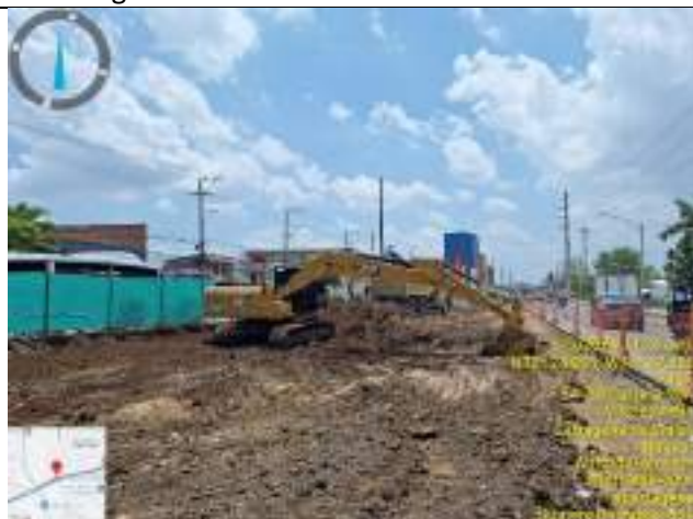
Imagen 12. Retiro de material de excavacion
