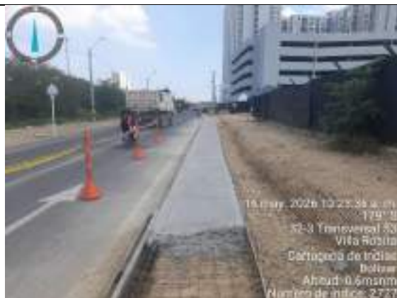
Imagen 15. Fundición de andenes en el lado derecho de la vía en conexión vial Territorio Mio – Parque Heredia
