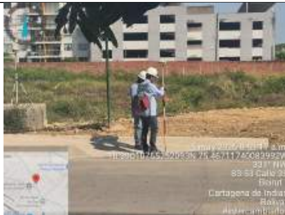
Imagen 10. Levantamiento de andenes y bordillo en punto de empalme de la via existente de territorio mio con la ejecutada
