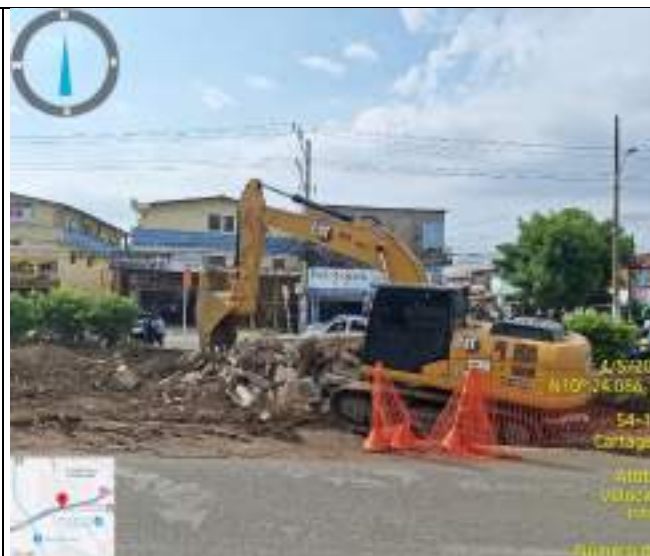
Imagen 2. Excavación para mejoramiento de la estructura de vía temporal en el sentido El amparo – Pozon, en el separador
