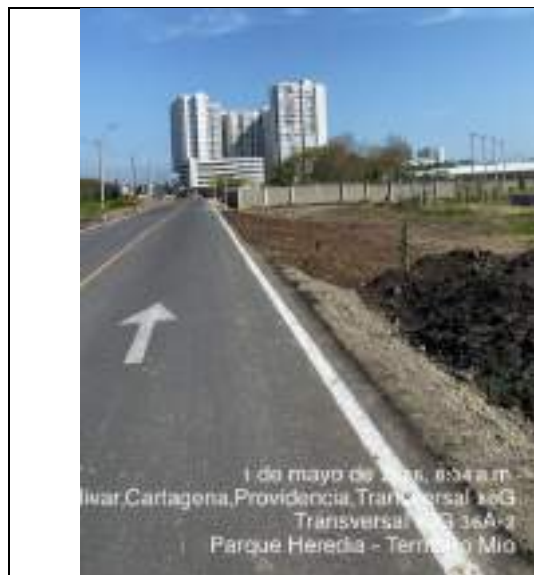
Imagen 1. Conformación de hombros de la vía en conexión vial Territorio mío – Parque Heredia
