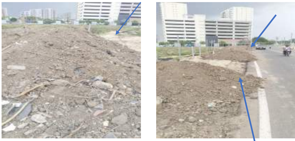
Imagen 1y 2: material acopiado sin medidas de control ambiental al lado de una vía transitada
