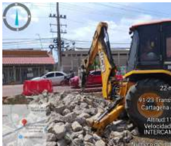
Imagen 7. Demolicion de anden en separador
