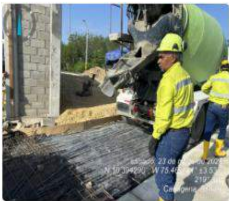
Ilustración: Acopio material y suministro de concreto en obra
