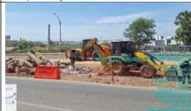
Imagen 4. Demolicion de andenes y relleno con material seleccionados en separador
