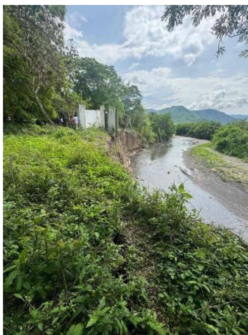
Figura 11. Visita de campo punto crítico 11
