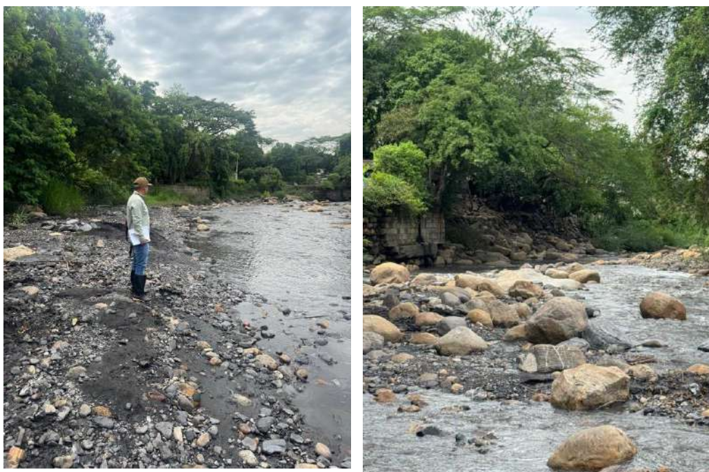
Figura 1. Visita de campo punto crítico 1
