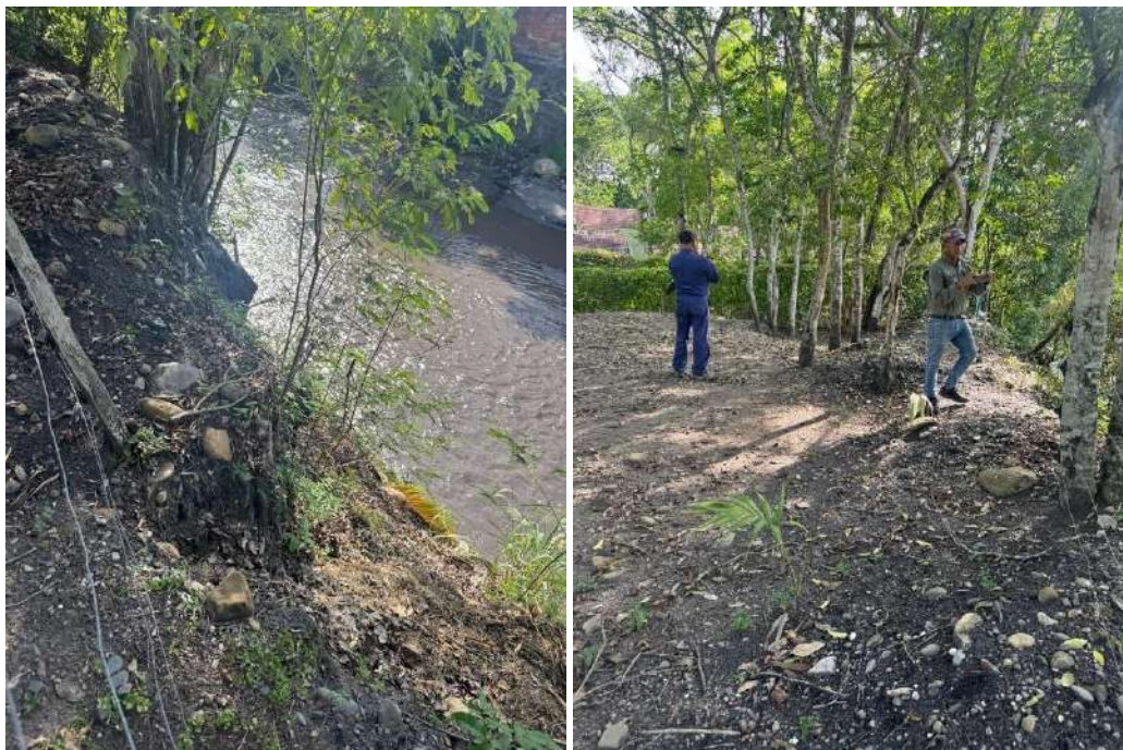
Figura 16. Visita de campo punto crítico 16
