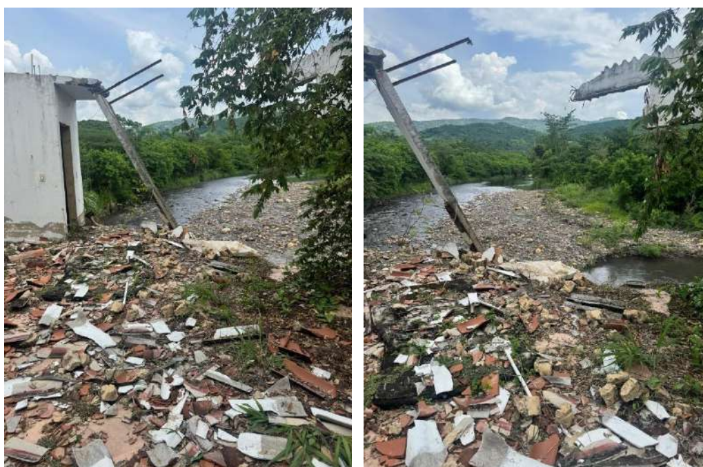
Figura 7. Visita de campo punto crítico 7
