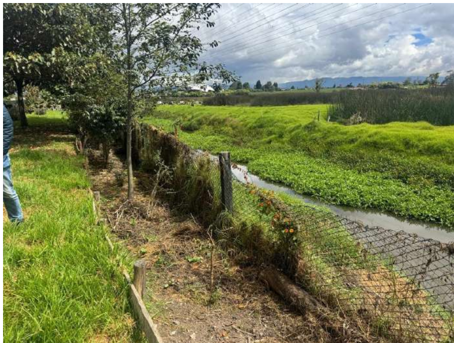
Figura 30. Visita de campo punto crítico 30
