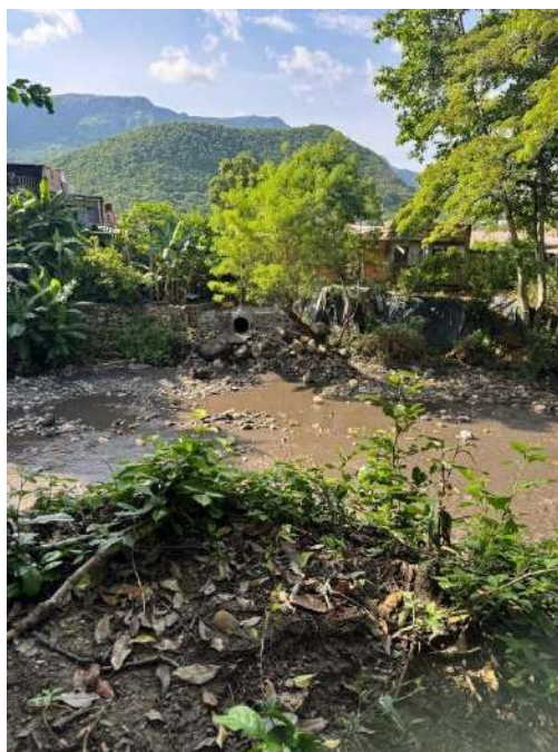
Figura 15. Visita de campo punto crítico 15
