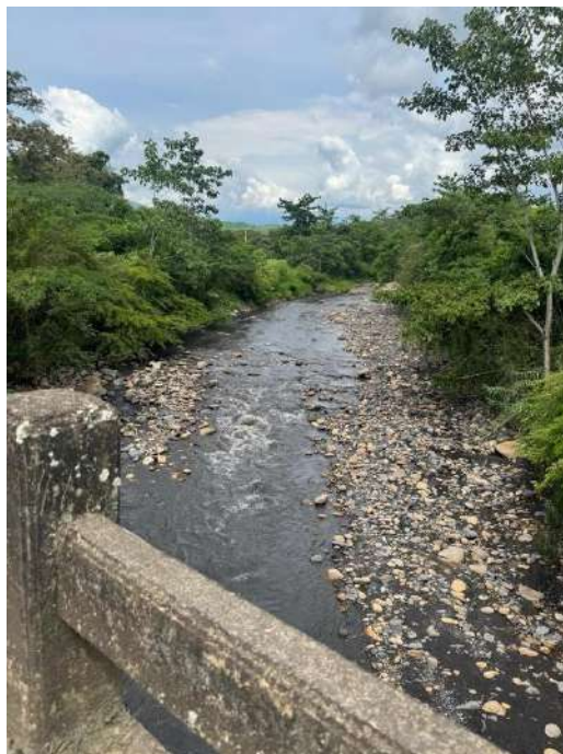
Figura 10. Visita de campo punto crítico 10
