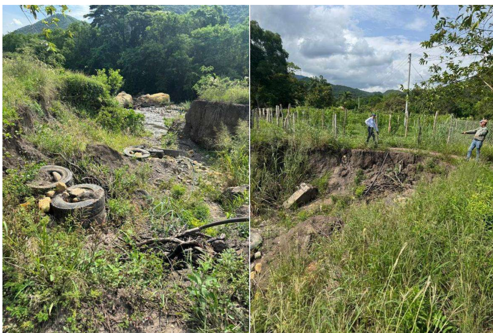
Figura 13. Visita de campo punto crítico 13
