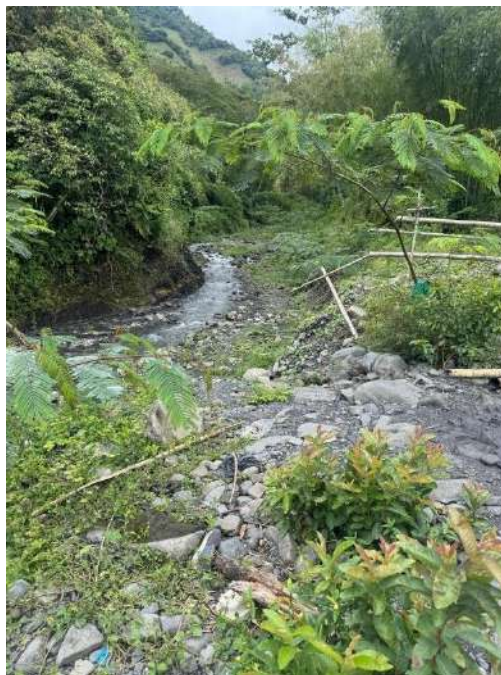
Figura 34. Visita de campo punto crítico 34
