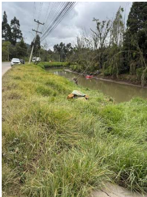
Figura 22. Visita de campo punto crítico 22
