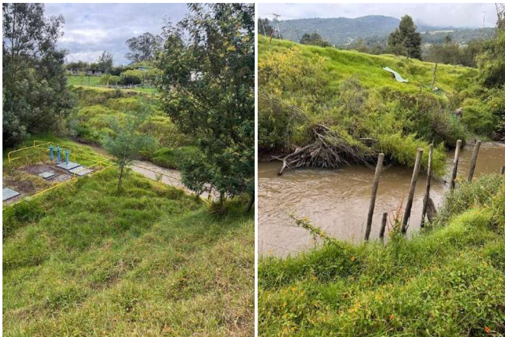
Figura 18. Visita de campo punto crítico 18
