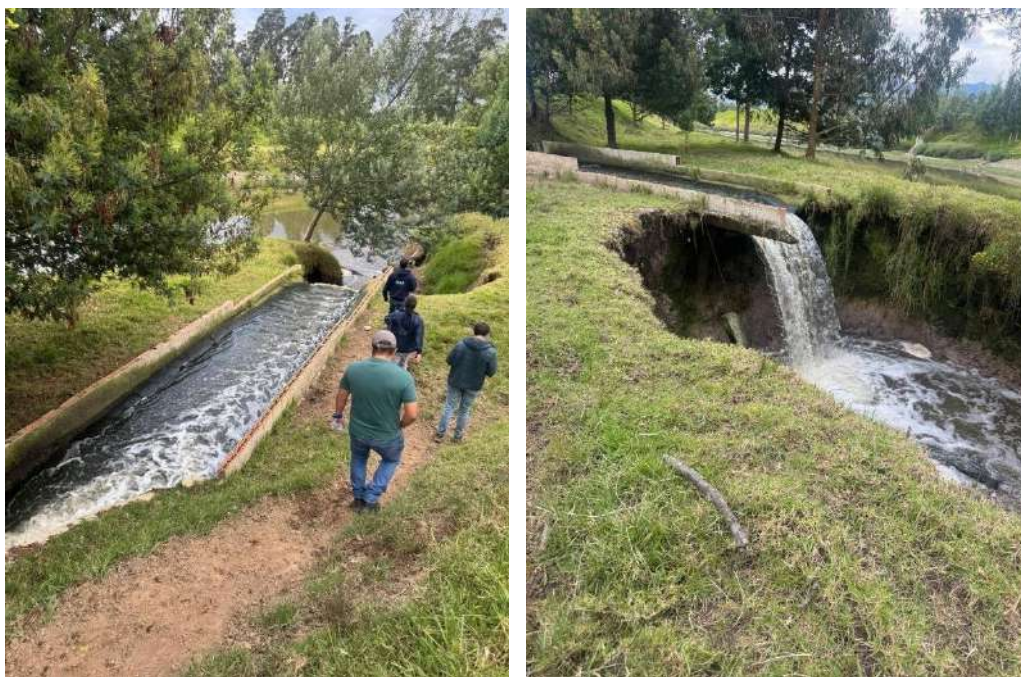
Figura 25. Visita de campo punto crítico 25
