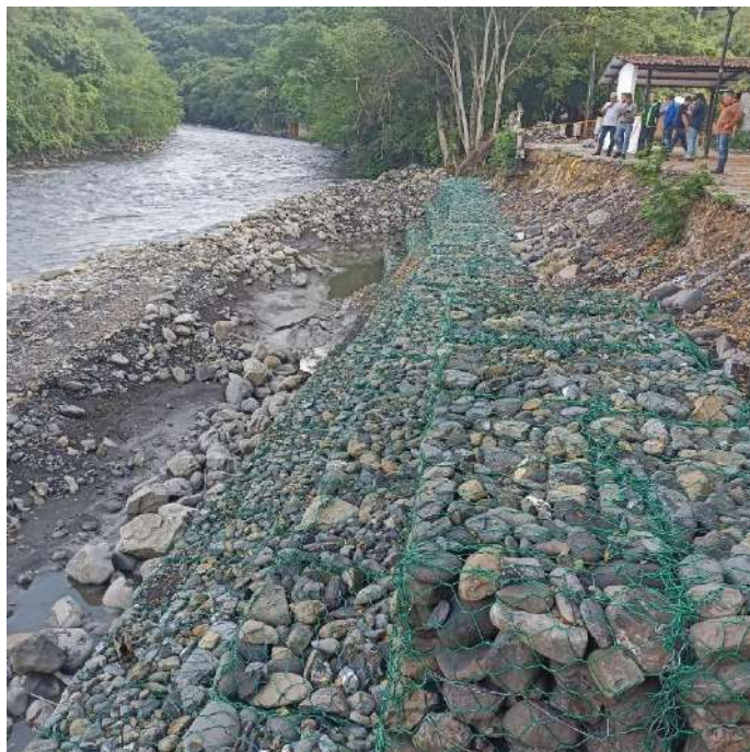
Figura 32. Visita de campo punto crítico 32
