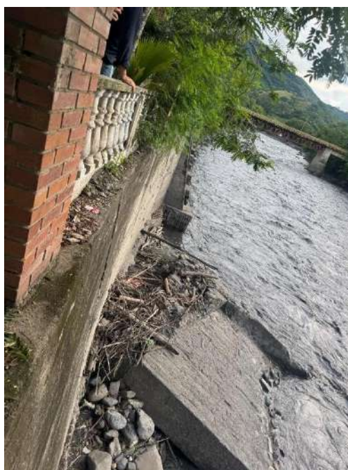
Figura 33. Visita de campo punto crítico 33
