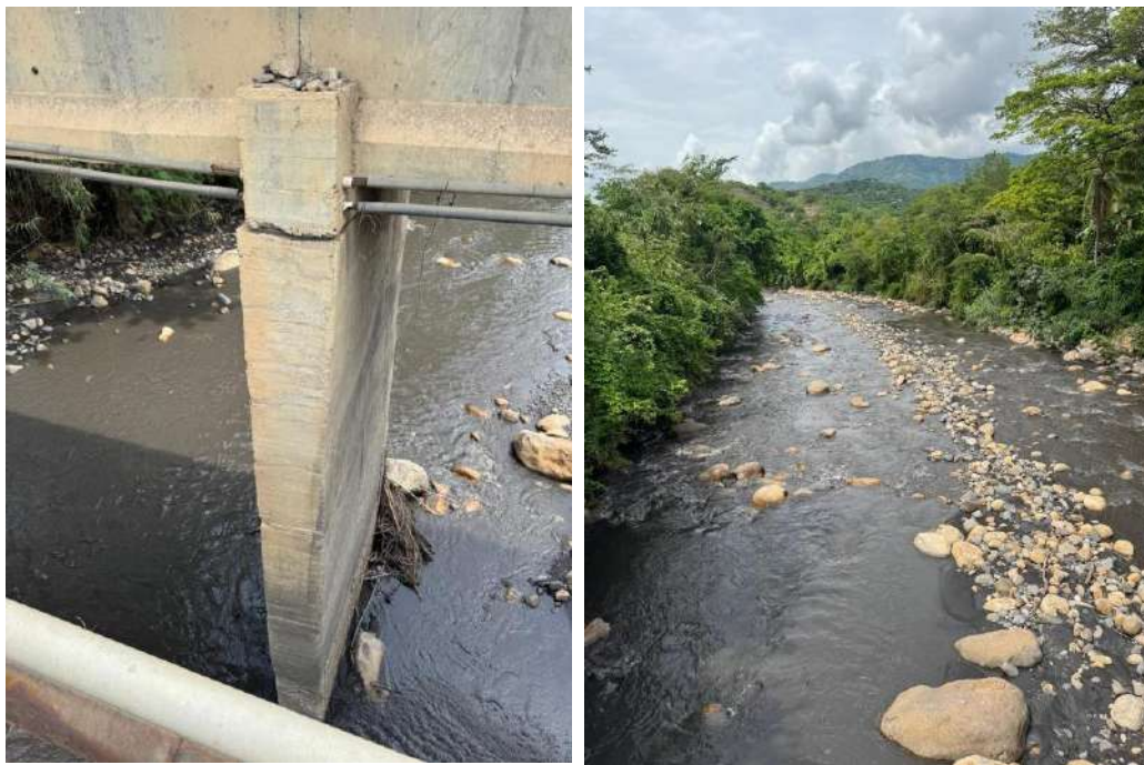
Figura 2. Visita de campo punto crítico 2
