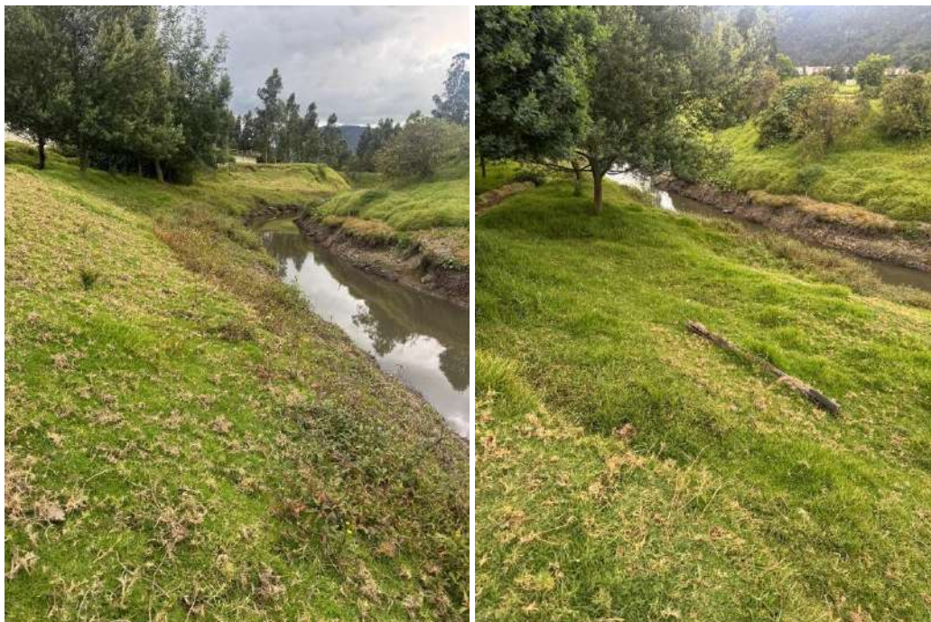
Figura 24. Visita de campo punto crítico 24
