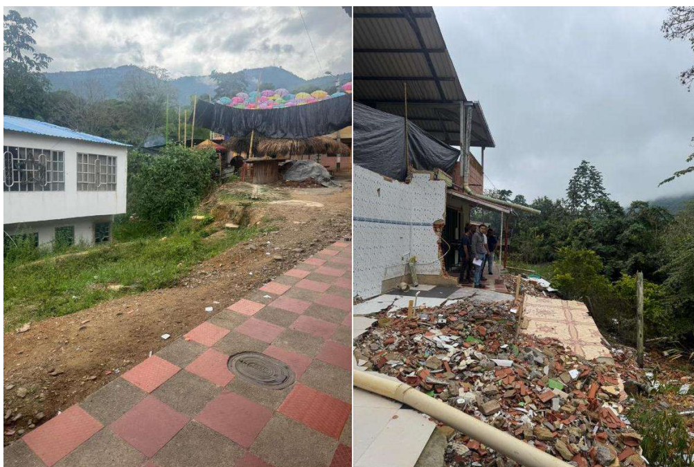
Figura 31. Visita de campo punto crítico 31
