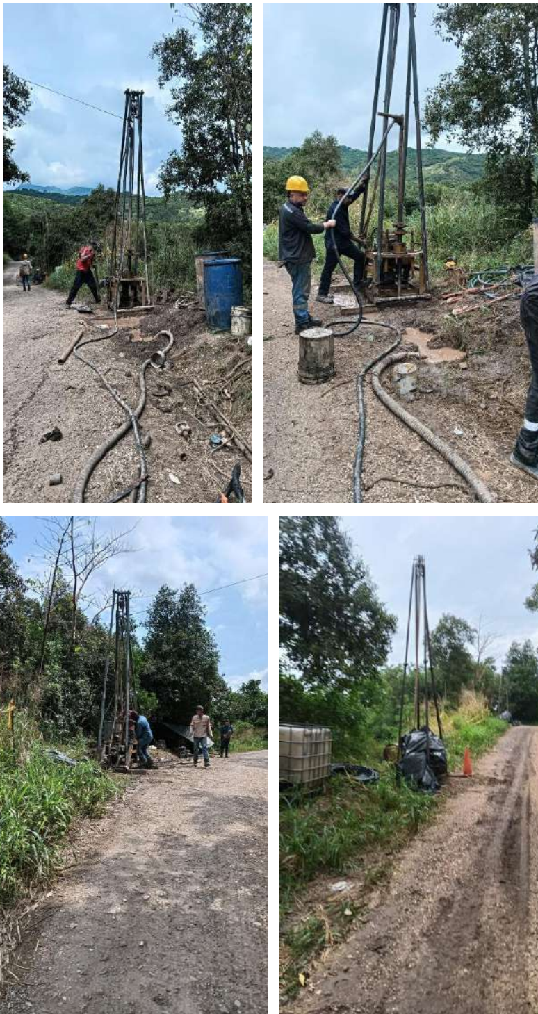
Figura 10. Registro fotográfico prospección geotécnica punto crítico No. 09
