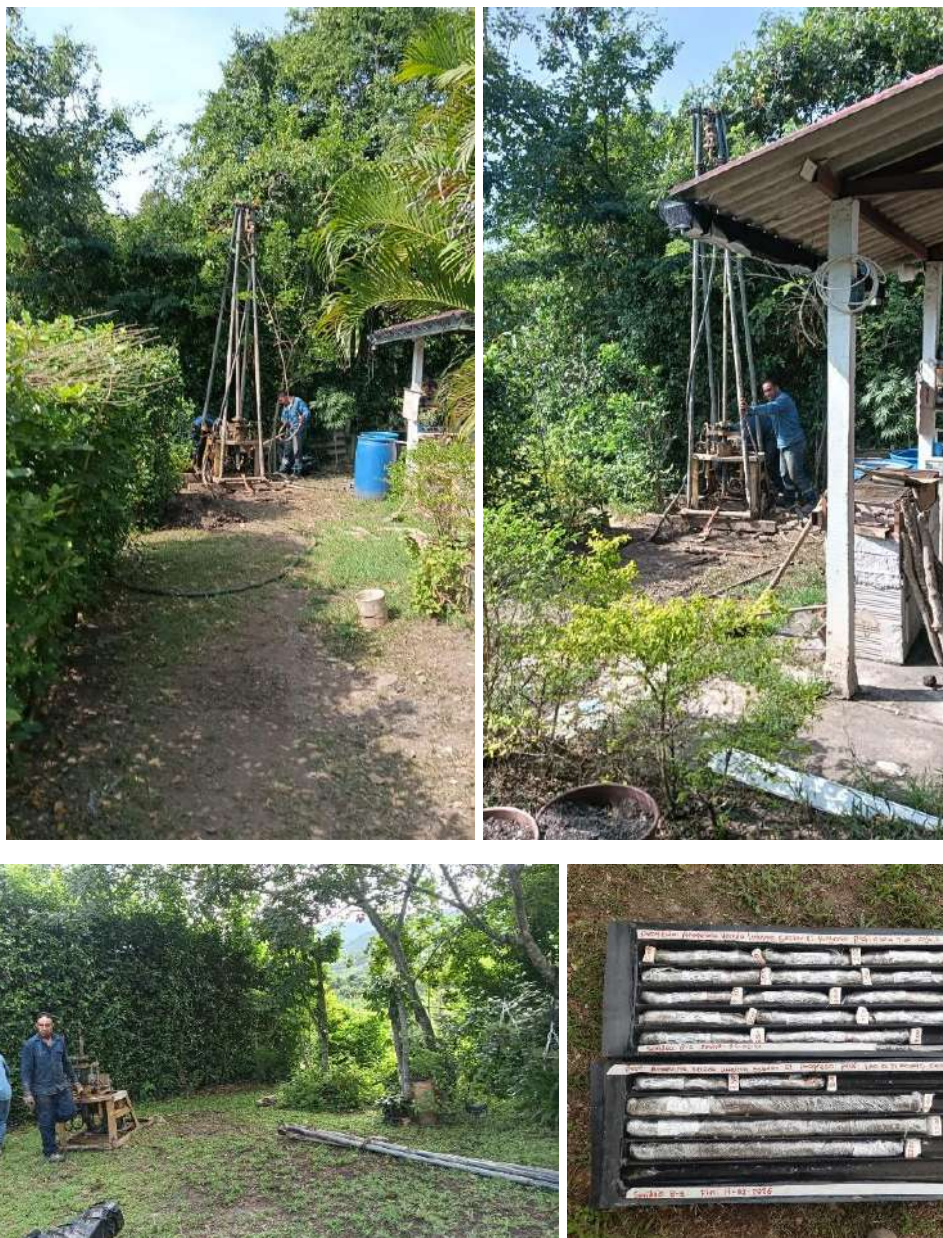
Figura 9. Registro fotográfico prospección geotécnica Punto Crítico No. 08
