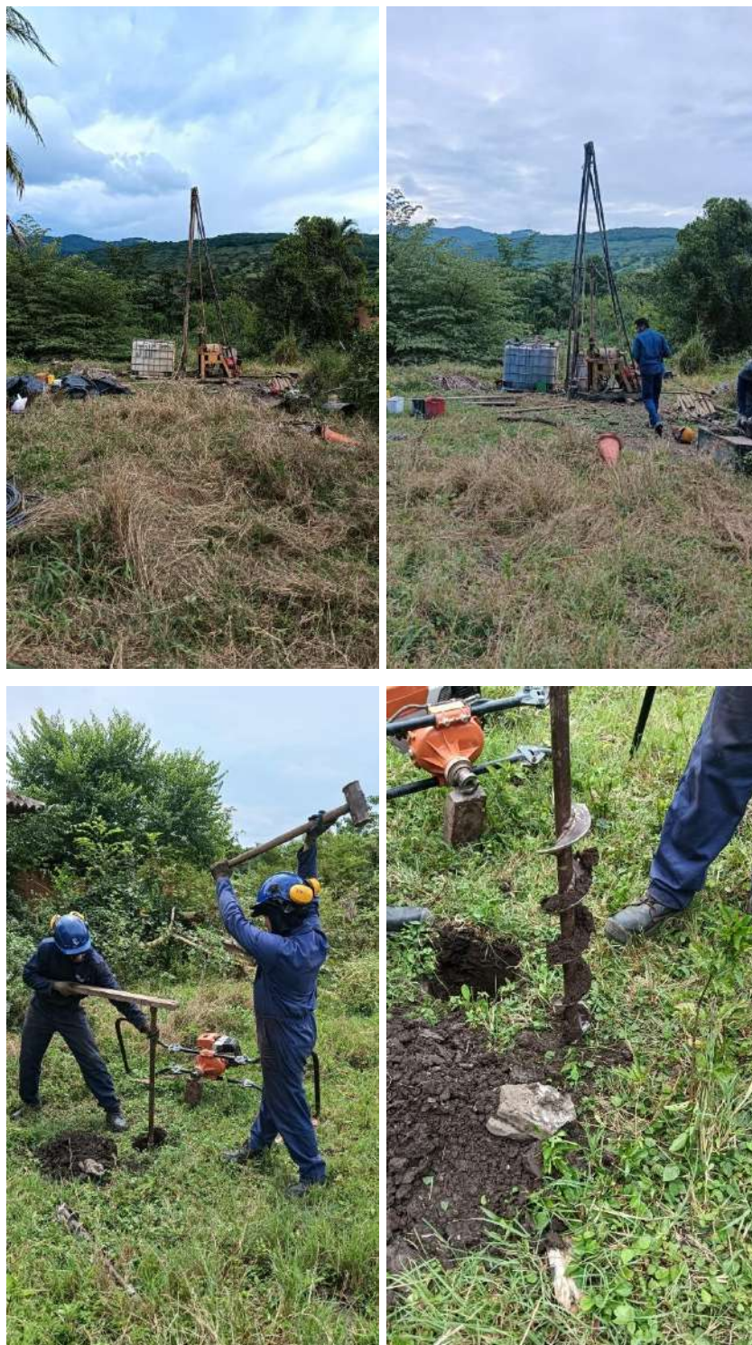
Figura 8. Registro fotográfico prospección geotécnica Punto Crítico No. 07
