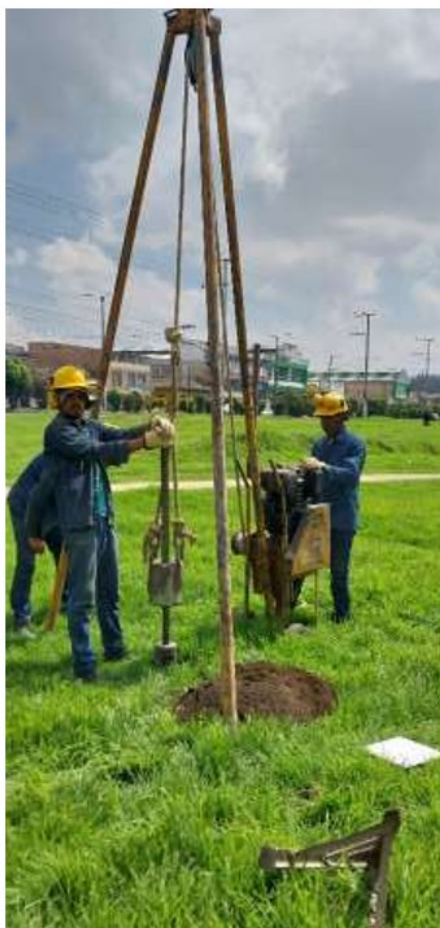
Fotografía 2: Realización de ensayo de penetración estándar SPT en sitio de estudio.
