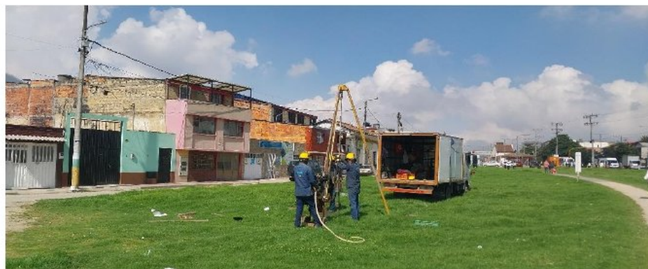
Realización de sondeo y extracción de muestras.
