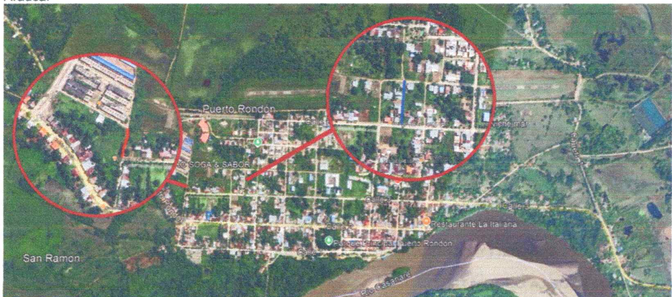
Figura 1. Localización de la vía
