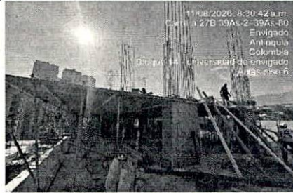
DESCRIPCIÓN: Avance ejecución Bloque Aulas P6 y montaje losa P7
