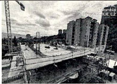
DESCRIPCIÓN: Avance ejecución Bloque de Biblioteca P5
