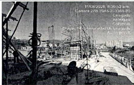
DESCRIPCIÓN: Avance ejecución Bloque Aulas P6
