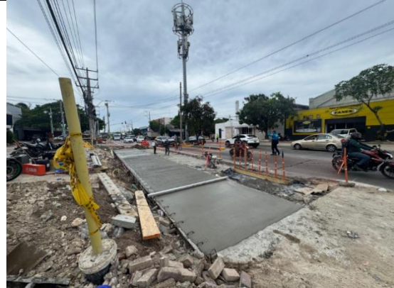
Vaciado de concreto MR-5
