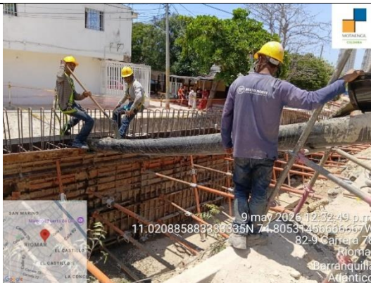
Vaciado de concreto de 4000psi para Muros de Canal
