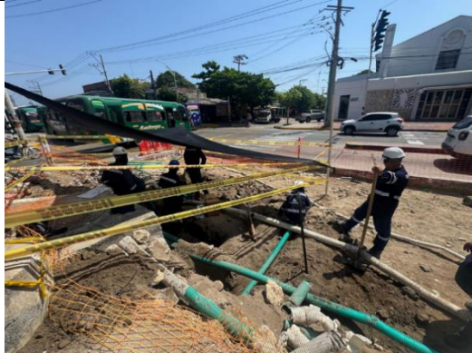
Reubicación de tuberías de redes existentes
