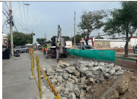
Demoliciones de pavimento via 40
