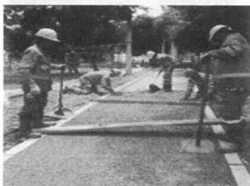
Colocación concreto permeable pista trote
