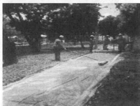
Colocación concreto permeable pista trote
