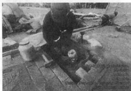
Ensayo de cono de arena para verificar densidad a la base instalada
