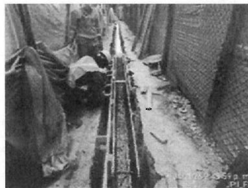
Construcción viga cerramiento externo
