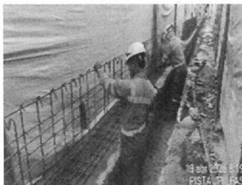
Construcción viga cerramiento externo
