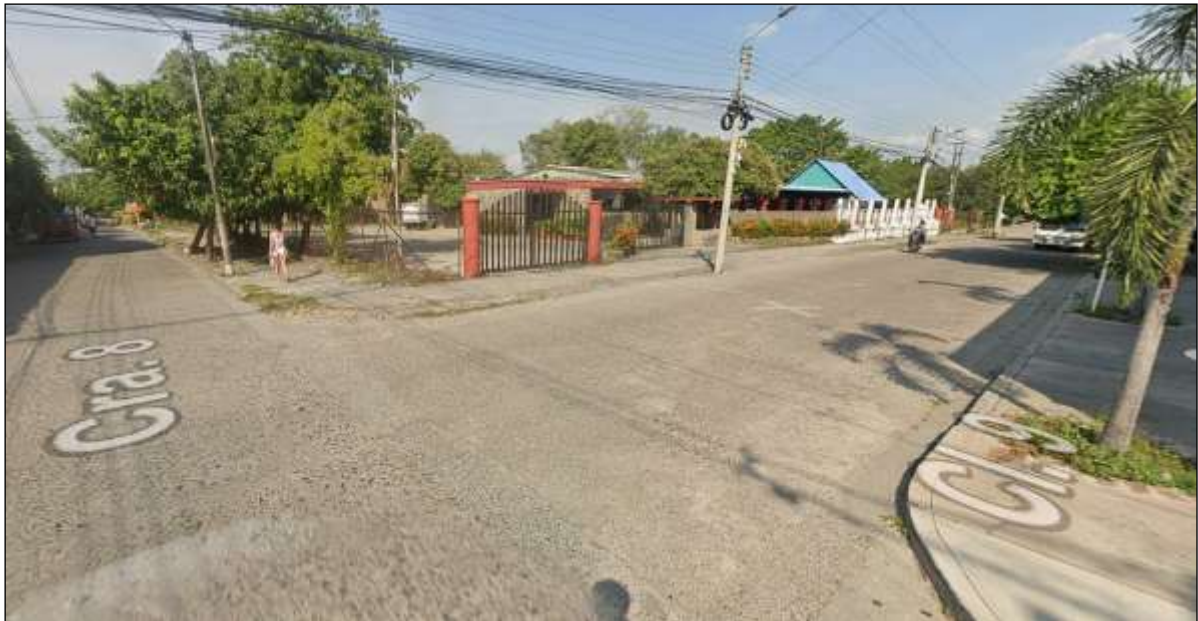
Fig. 1 Vista del Hotel Lemaya desde la Esquina de la Carrera 8ª con calle 9.
