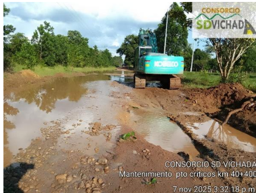
Ilustración 5 Mantenimiento - Atención de Punto Crítico K40+400
