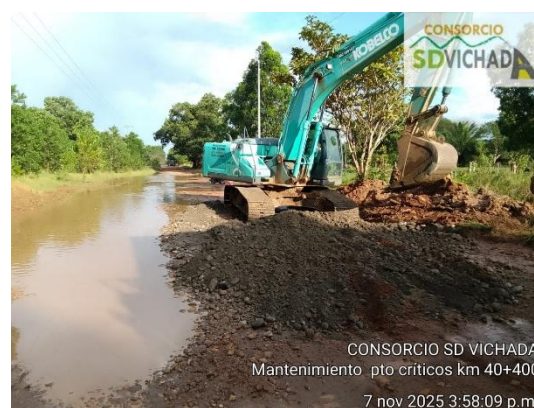
Ilustración 6 Mantenimiento Sitio Crítico en el K36+390.
