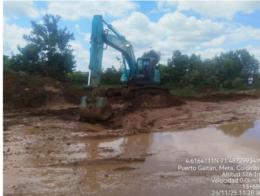
Ilustración 8 Mantenimiento Sitio Critico en el K13+680.
