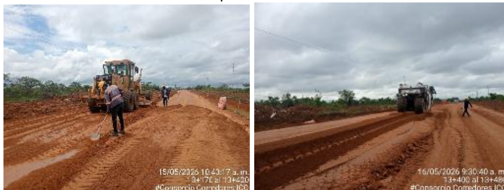
Ilustración 5 Construcción de terraplén
