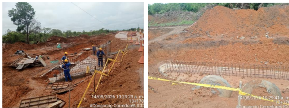
Imagen 5 Amarre del acero de refuerzo de las alcantarillas
