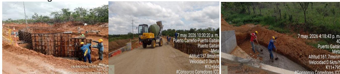
Imagen 4 Construcción de alcantarillas en Concreto reforzado de 28 MP
