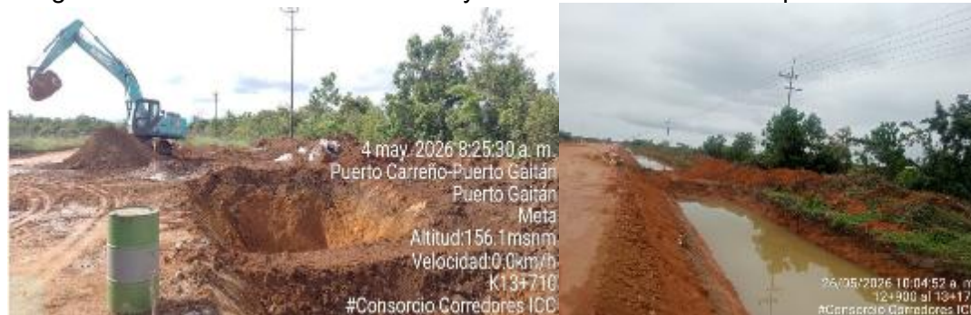
Imagen 3 Excavación del canal lateral y obtención de material de préstamo
