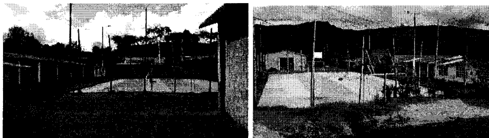
Figura 1. Estado actual del lugar de ejecución del proyecto.
