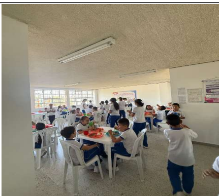
FOTO No 7 PINTURA DE MUROS Y CIELO RASO DE COMEDOR IE MALHABAR SEDE A - JOSÉ RUFINO
