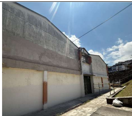
FOTO No 8 INSTALACIÓN DE REVOQUE DE MUROS IE MALHABAR SEDE A - JOSÉ RUFINO
