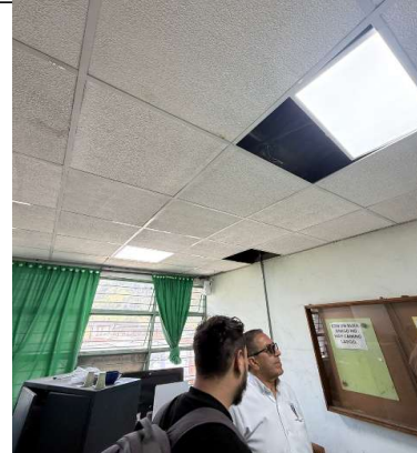
FOTO No 2 INSTALACIÓN DE LUMINARIAS IE MALHABAR SEDE B - FRANCISCO GIRALDO
