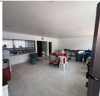
FOTO No 6 PINTURA DE MUROS Y CIELO RASO DE COCINA IE MALHABAR SEDE A- JOSÉ RUFINO
