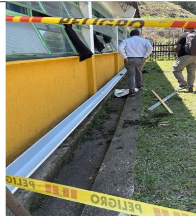
FOTO No 4 CANAL NUEVA PARA INSTALACIÓN IE MALHABAR SEDE B - FRANCISCO GIRALDO
