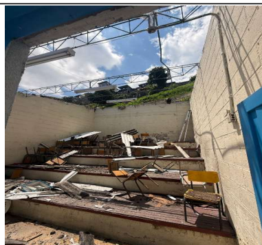
FOTO No 10 DESMONTE DE CUBIERTA AFECTADA IE DOMINGO SAVIO
