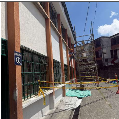
FOTO No 5 -PINTURA DE FACHADA IE MALHABAR SEDE A - JOSÉ RUFINO
