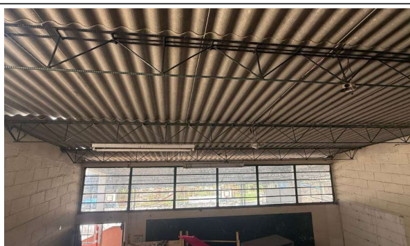
FOTO No 9 INSTALACION DE TEJAS IE DOMINGO SAVIO
