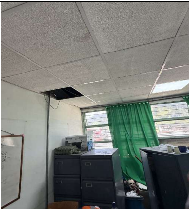
FOTO No 3 INSTALACIÓN DE REDES ELECTRICAS AULA DE PROFESORES IE MALHABAR SEDE B - FRANCISCO GIRALDO
