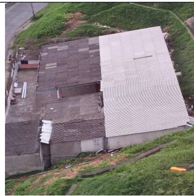
FOTO No 10 INSTALACIÓN DE TEJAS NUEVAS IE DOMINGO SAVIO
