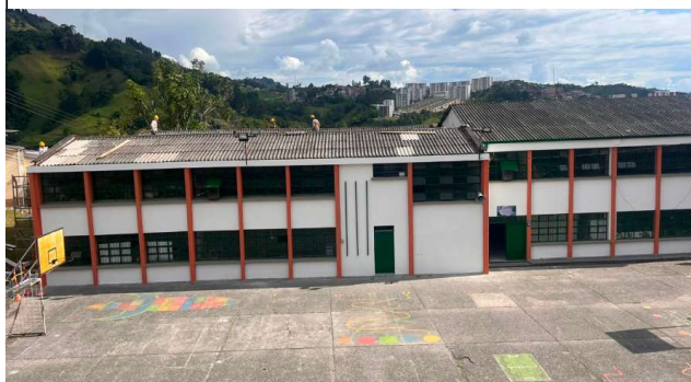
FOTO No 5 -PINTURA DE FACHADA IE MALHABAR SEDE A - JOSÉ RUFINO
