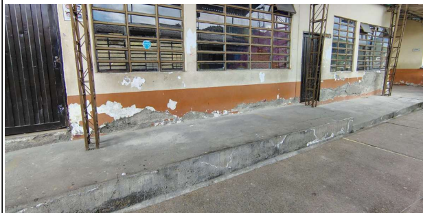
FOTO No 4 DEMOLICIÓN DE REVOQUE IE MALHABAR SEDE PRINCIPAL
