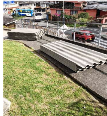
FOTO No 8 . MATERIAL PARA REPOSICIÓN DE CUBIERTA DETERIORADA
