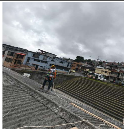
FOTO No 6 RECORRIDO DE CUBIERTA IE MALHABAR SEDE A- JOSÉ RUFINO
