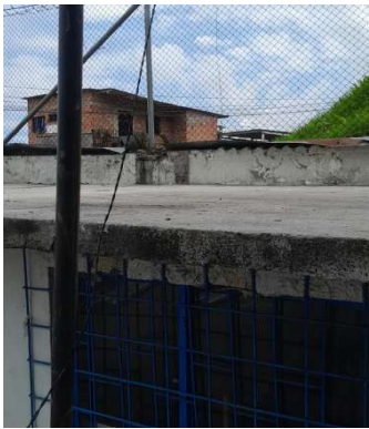
FOTO No 9 DESMONTE DE CUBIERTA BLOQUE ADMINISTRATIVO IE DOMINGO SAVIO
