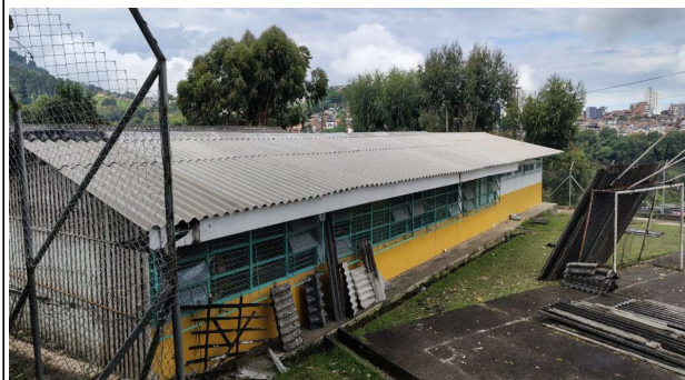
FOTO No 2 CAMBIO DE CUBIERTA DETERIORADA IE MALHABAR SEDE B - FRANCISCO GIRALDO
