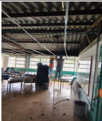
FOTO No1 INSTALACIÓN DE CIELO RASO IE MALHABAR SEDE B - FRANCISCO GIRALDO
